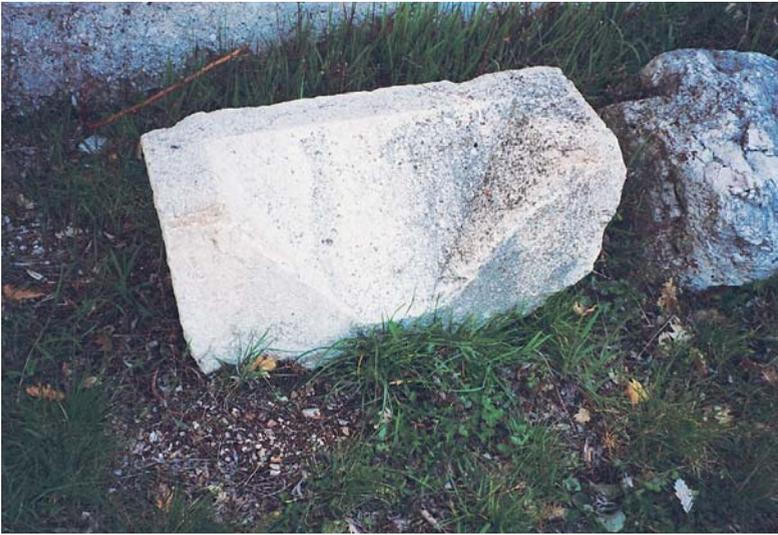
16/ Appunto di rilievo del frammento lapideo rinvenuto. Le dimensioni sono lievemente differenti per ciascuna finestrella; il disegno è invece perfettamente e inequivocabilmente riconducibile alla torre di San Salvatore. 17/ Particolare di una finestrella strombata del fronte sud della torre campanaria.
