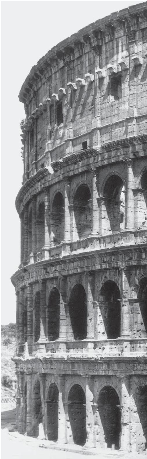
5/ Rilevamento fotogrammetrico di una porzione del fronte nord del Colosseo, con a fianco la sezione verticale che mostra l'arretramento del terzo e quarto ordine. L'arretramento tra il secondo e terzo ordine è di 0,40 m mentre quello complessivo è di 0,70 m.
