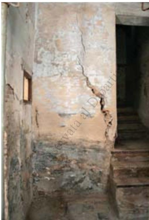
*Degrado dell'edificio:* tutti i solai risultano messi in crisi dalla spinta della torre. Sono comparse crepe all'interno del corpo scala e dei muri collegati alla struttura della torre. Si riscontra il sollevamento della pavimentazione al livello del terreno a causa del cedimento irregolare del terreno.
