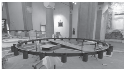
Fig. 17. L'assemblaggio di uno dei grandi lampadari a piè d'opera prima di essere posizionato alla quota prevista.
