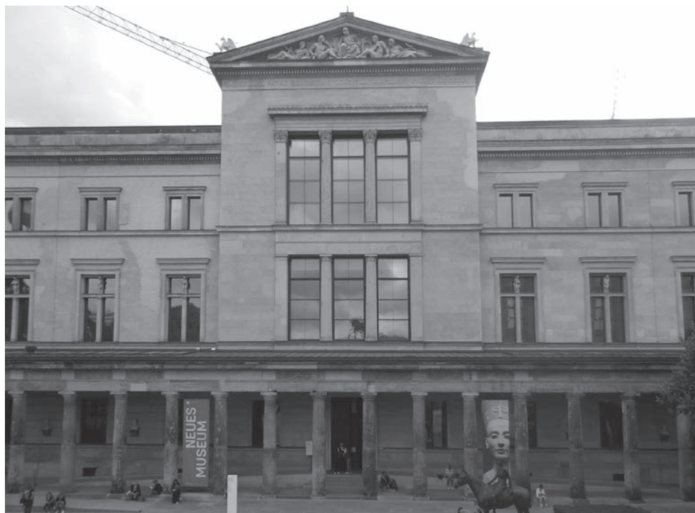
Fig. 1. La testata centrale e il portico ottocenteschi del Neues Museum nel fronte verso la Museuminsel di Berlino (foto D. Fiorani).
