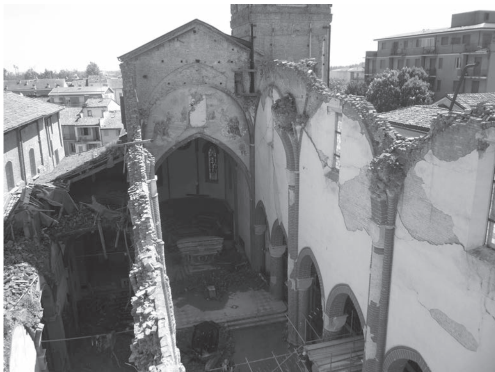
Fig. 1. Immagine della chiesa devastata: i muri del cleristorio sono ruotati e crollati nella parte superiore; si notano i mattoni allentati in una muratura caratterizzata da modesta coesione.
