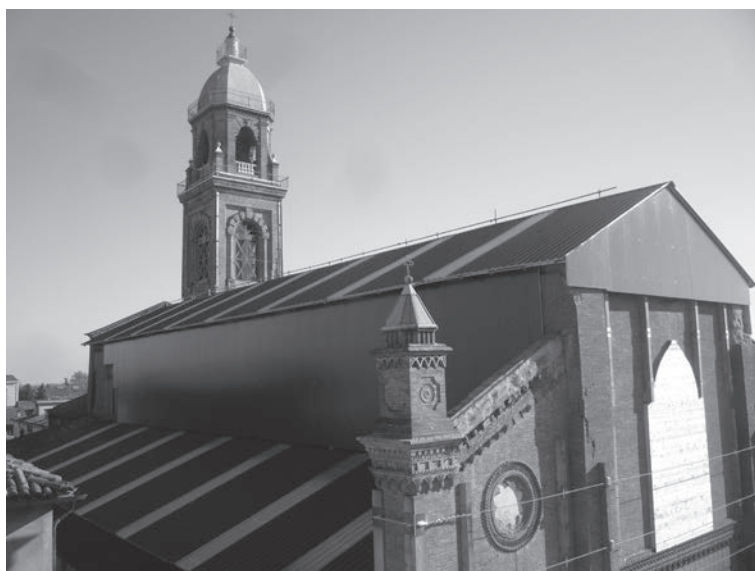
Fig. 6. La chiesa messa in sicurezza e dotata di una protezione provvisoria.
