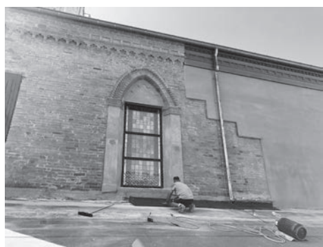
Fig.16. Ricostruzione del muro di destra del cleristorio, parzialmente crollato: le parti ricostruite sono state realizzate con pannelli leggeri con finitura a malta tipo cocciopesto.
