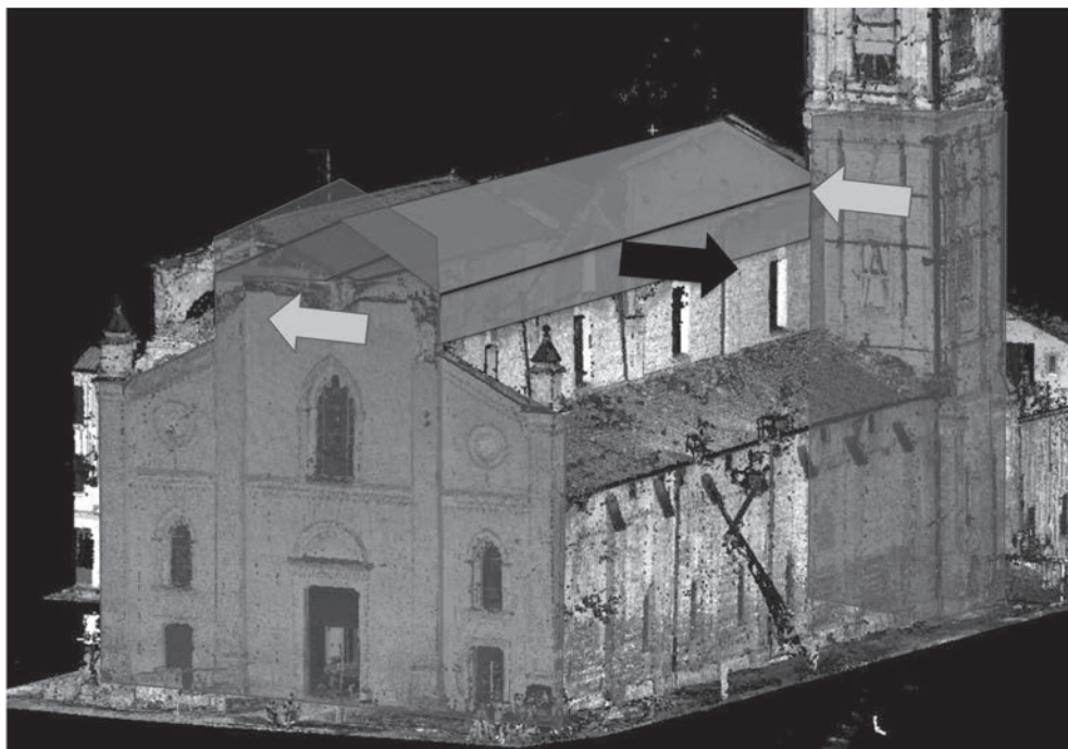
Fig. 8. La copertura come presidio antisismico: la struttura reticolare di copertura, in grado di trattenere i muri longitudinali e la facciata dal ribaltamento, scarica il proprio peso (contenuto) sulle colonne della navata centrale, ma trova contrasto alle oscillazioni trasversali nella facciata, nella base del campanile e nell'abside.
