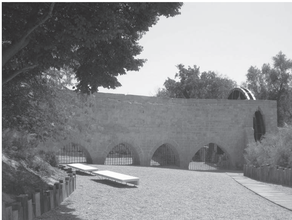
Fig. 3. Veduta parziale dell'acquedotto e della ruota (foto S. Mora 2011).
