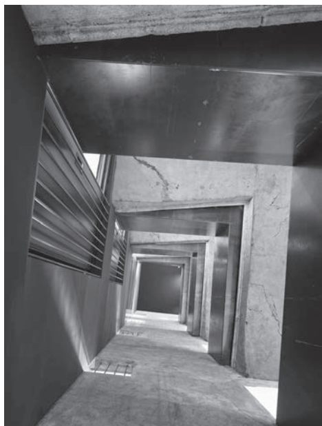
Fig. 11. La corte minore, detta 'corte nera' esprime la dialettica di apport et support mediante l'apposizione di una lamiera metallica che consolida il ballatoio e ne amplifica lo spazio utile (©Ateliers Jean Nouvel).
