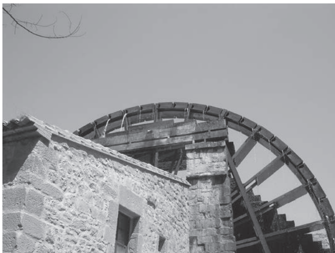
Fig. 4. Particolare della ruota del monastero, dopo i restauri (foto S. Mora 2011).
