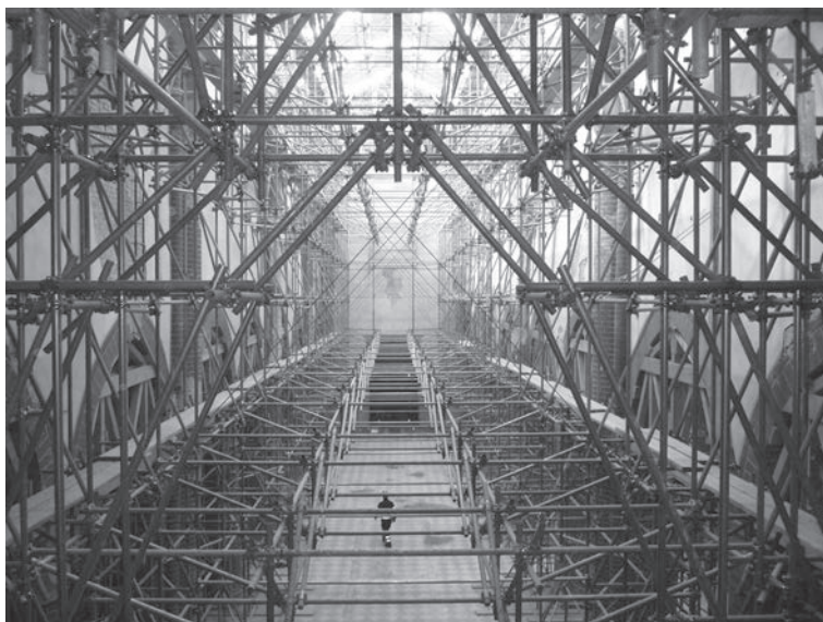
Fig. 5. I ponteggi interni e le centine lignee a sostegno degli archi, realizzati dai Vigili del Fuoco.
