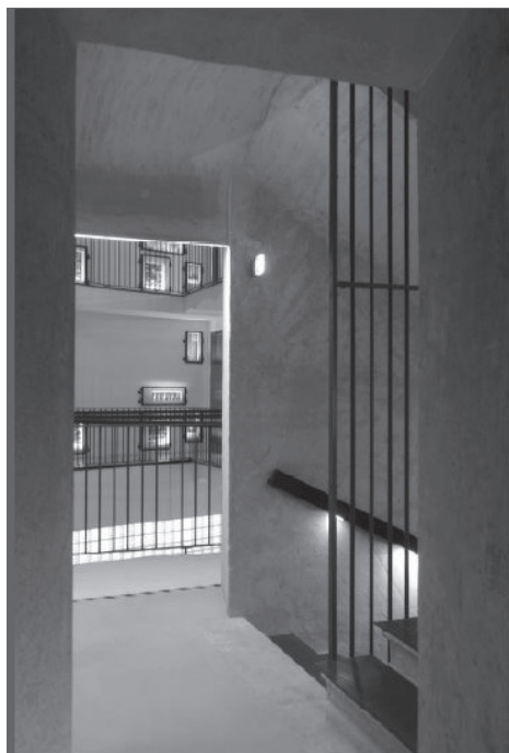
Fig. 12. Le prime due rampe della scala sono completamente realizzate ex novo mediante gradini in lamiera piegata installati a sbalzo a partire da un cosciale aderente alla muratura e ad essa inghisato con barre passanti. La porzione di scala esistente, in muratura, viene consolidata con una fasciatura all'estradosso con fibra d'acciaio e rivestita da una lamiera metallica che ne allarga le pedate. Inoltre, per minimizzare gli interventi sul muro, i corpi illuminanti vengono alloggiati nel mancorrente (©Ateliers Jean Nouvel).
