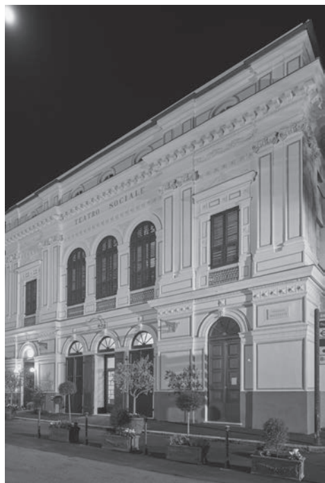
Fig. 5. Esterno del teatro dopo la fine dei restauri, in cui si ripropone la bicromia tipica genovese.
