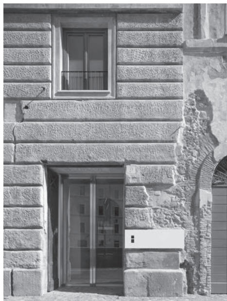
Fig. 13. Il prospetto su via del Velabro dopo l'intervento. Il restauro delle superfici ha inteso conservare tutto ciò che potesse testimoniare il passaggio del tempo e "consentire la scoperta di un edificio che senza chirurgia estetica ha smesso di invecchiare" (@Ateliers Jean Nouvel).
