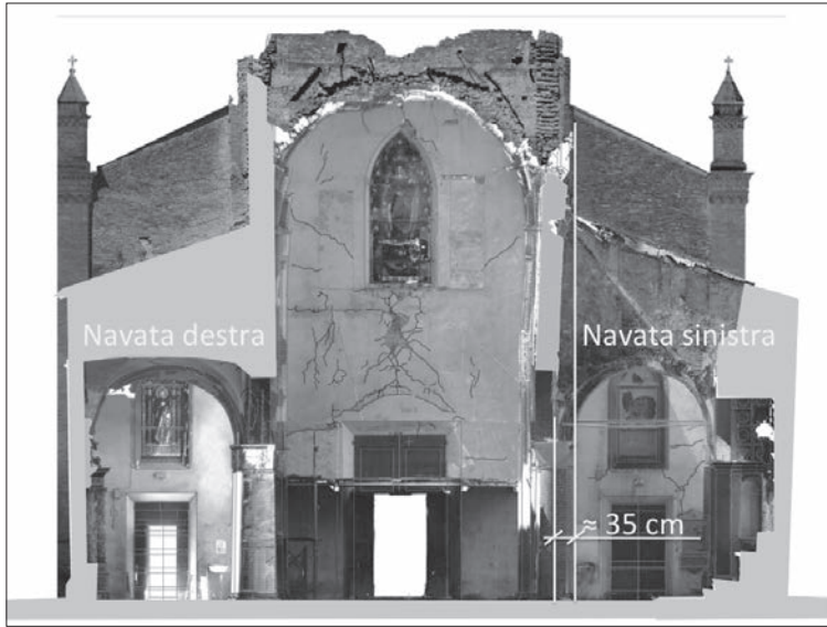
Fig. 3. Ortofoto dal rilievo laser-scanner (con fuori-piombo di circa 35 cm su ogni lato).
