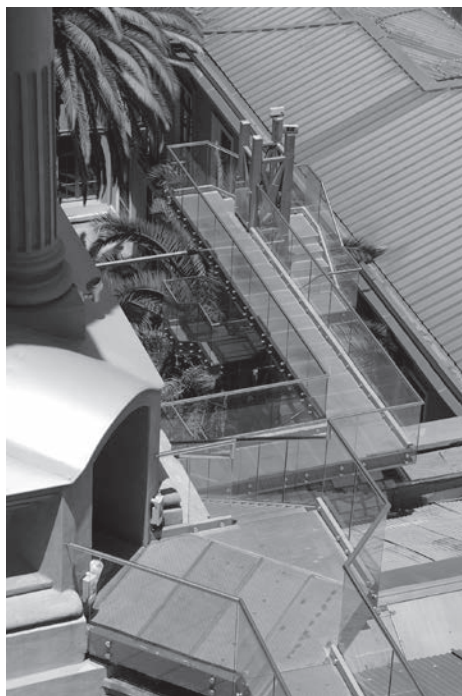
Fig. 11. Veduta della scala con le passerelle per l'accesso al tetto, dopo il restauro (foto dell'autore).
