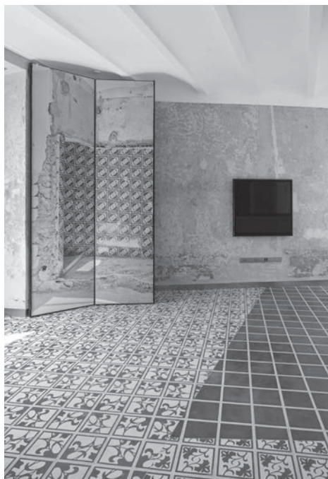
Fig. 8. Il rivestimento degli elevati esistenti viene riproposto in pianta, modificandone il motivo decorativo con la variazione di scala, inoltre la traccia dei muri preesistenti demoliti viene suggerita dalla variazione di pavimentazione (@Ateliers Jean Nouvel).
