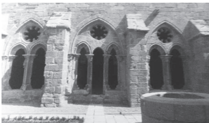
Fig. 6. Il chiostro, veduta parziale dopo i recenti restauri (da IBARGUEN SOLER 2003, p. 39).
