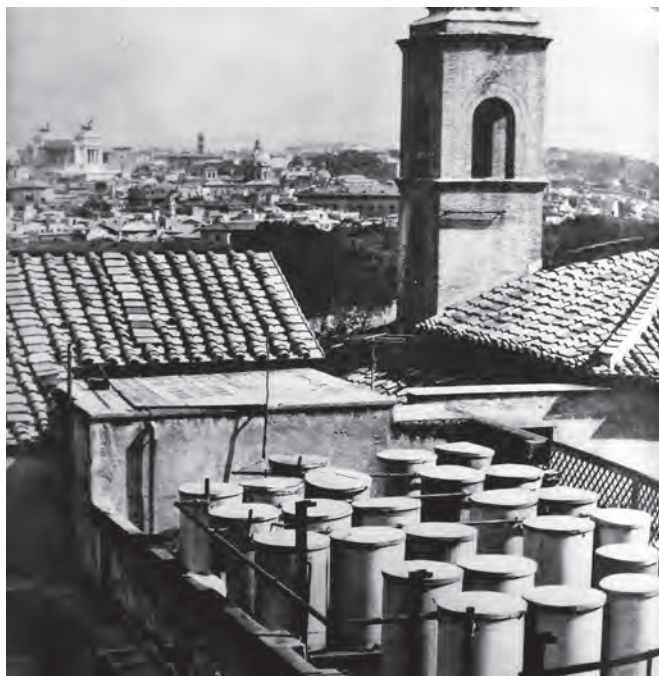
Fig. 4. I singoli cassoni delle utenze dell'acqua Marcia, che saranno progressivamente sostituiti dall'Acqa con i contatori (da ACEA 1959).
