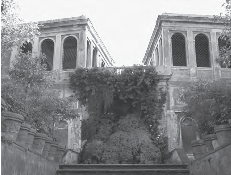
Fig. 1. Roma, Horti farnesiani sul Palatino, ninfeo sottostante le uccelliere (foto 2015). Prima del recente restauro la rigogliosa crescita vegetale impediva la lettura del ninfeo nei suoi valori architettonici e in rapporto all'impianto del giardino, di cui costituisce un fuoco prospettico.
