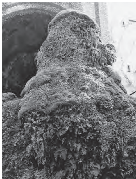
Fig. 4. Tivoli, villa d'Este, Cento fontane, dettaglio di un giglio nella parte centrale (foto 2000). L'involucro che avvolge e nasconde gli elementi scultorei è un misto di calcare e colonizzazioni biologiche: il calcare riveste e imprigiona la maglia creata da radici, fusti e filamenti degli organismi che colonizzano la superficie e che continuano ad accrescersi verso l'esterno per svolgere la fotosintesi (da LISERRE 2003, p. 60).
