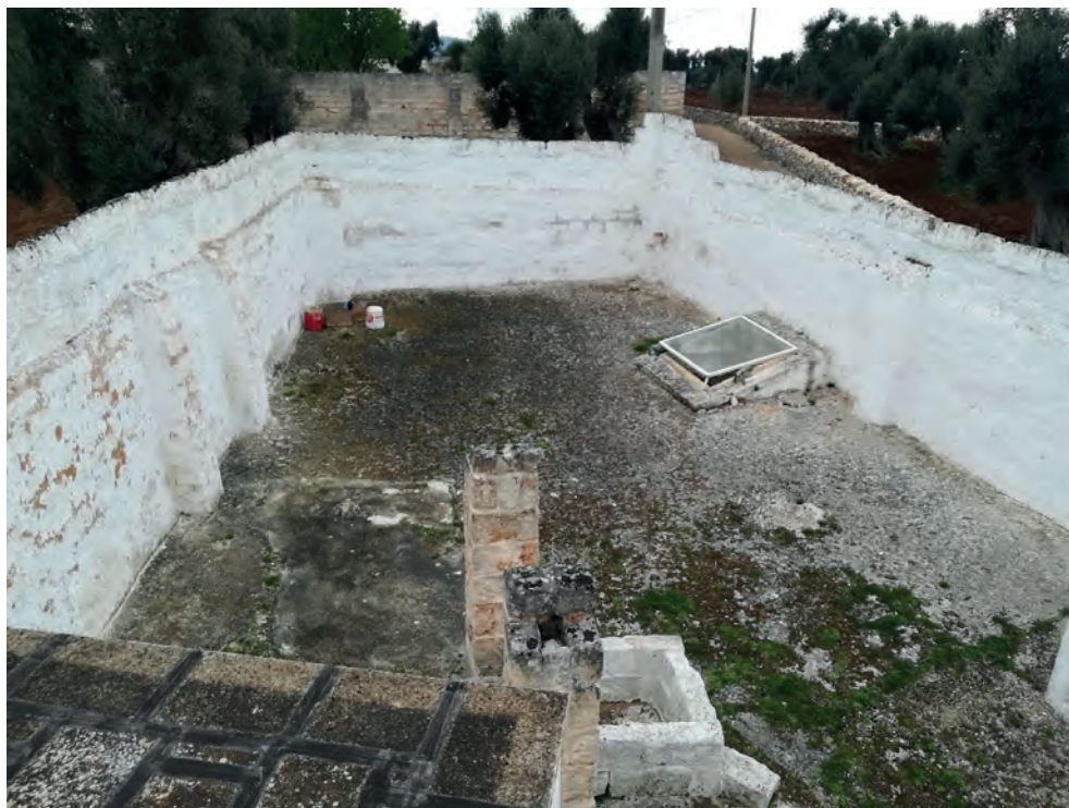
Fig. 2. Estradosso del lastrico solare prima dell'intervento di restauro conservativo. Colonie di muschi (verdi) e licheni (neri) rivestono omogeneamente l'intera superficie; i lacunari sono occlusi da infissi in anticorodal; le superfici murarie manifestano fenomeni di esfoliazione del latte di calce, aggredito dalla grandine e dilavato dalle acque meteoriche. In primo piano il boccale di una cisterna, alla cui sinistra si estende una reintegrazione impropria a base di malta cementizia.
