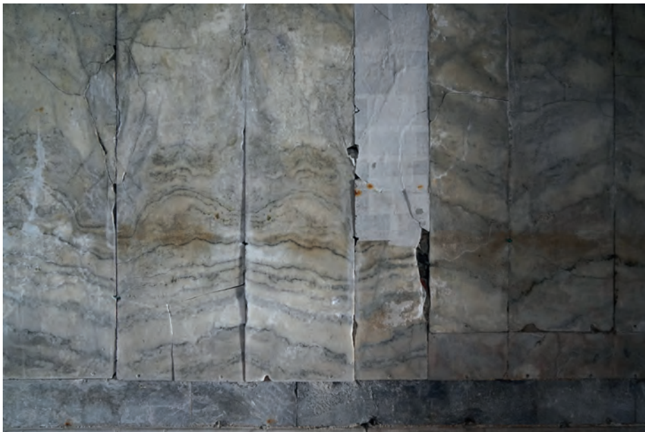
Fig. 3. Lo stato di degrado delle crustae marmore del narcece, provocato dai cicli di cristallizzazione salina.
