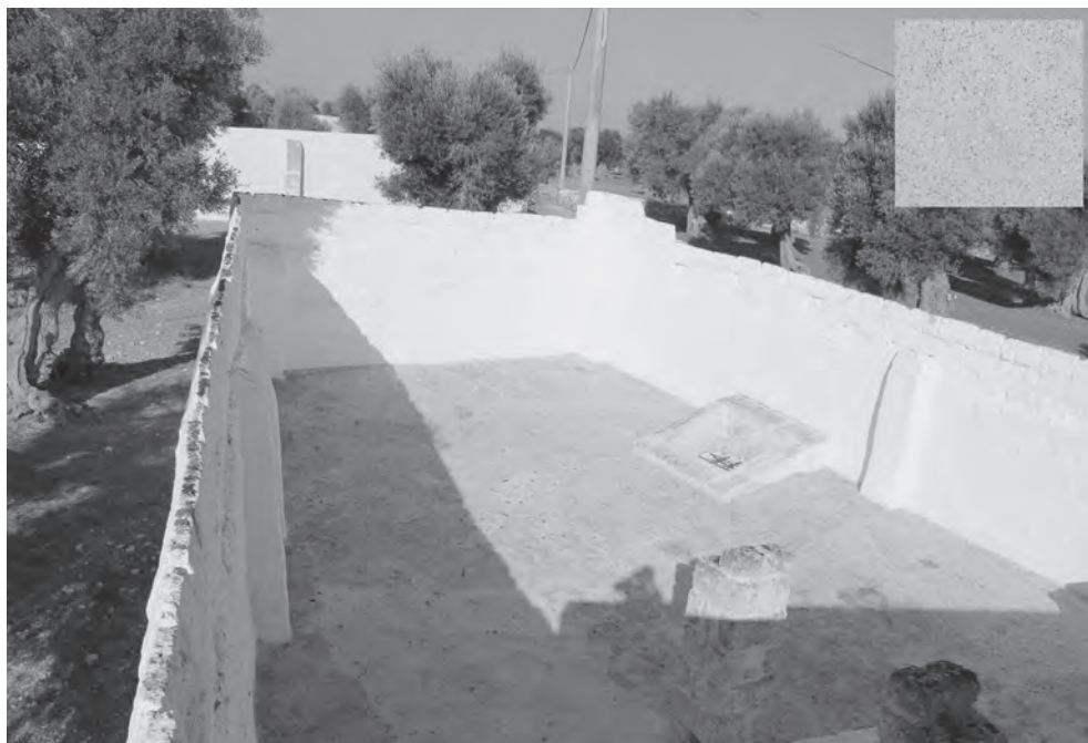
Fig. 5. Reintegrazione dell'immagine d'insieme dell'estradosso del lastrico solare (battuto di terra), dopo l'intervento di pulitura, reintegrazione e protezione superficiale (dicembre 2020).
