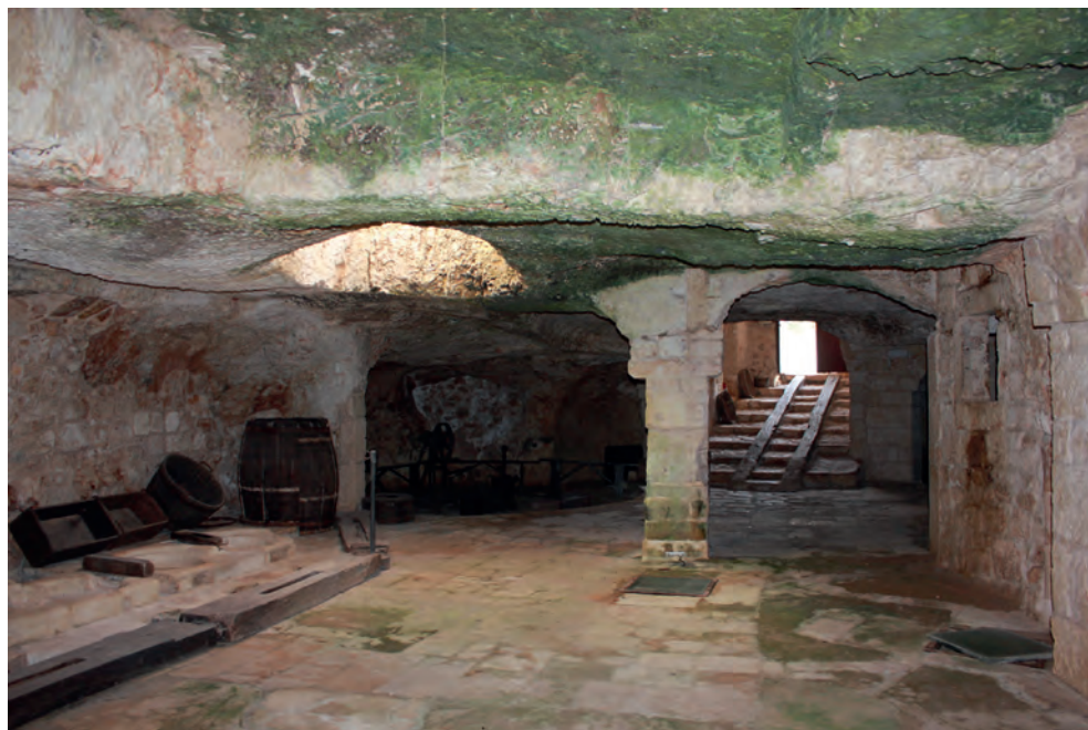
Fig. 1. Frantoio ipogeo di Locopagliaro, marina di Ostuni (BR), secolo XII: interno ripreso dalla cordonata di accesso. Si rilevano fenomeni diffusi di degrado chimico-fisico, generati dallo stillicidio dell'acqua carsica da percolazione: muschi e licheni; acque disperse sul pavimento; croste e depositi salini.
