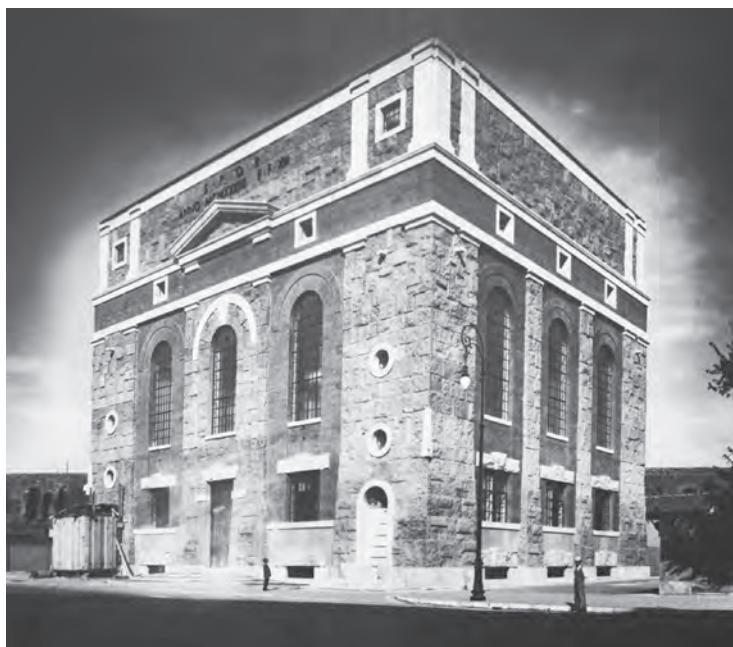
Fig. 6. Foto del serbatoio a fine lavori (SIMU, Stoelcker Rodolfo – completamento dei serbatoi innaffiamento in via Eleniana , anno 1935, titolo 9, classe 8/11, fasc. 27).
