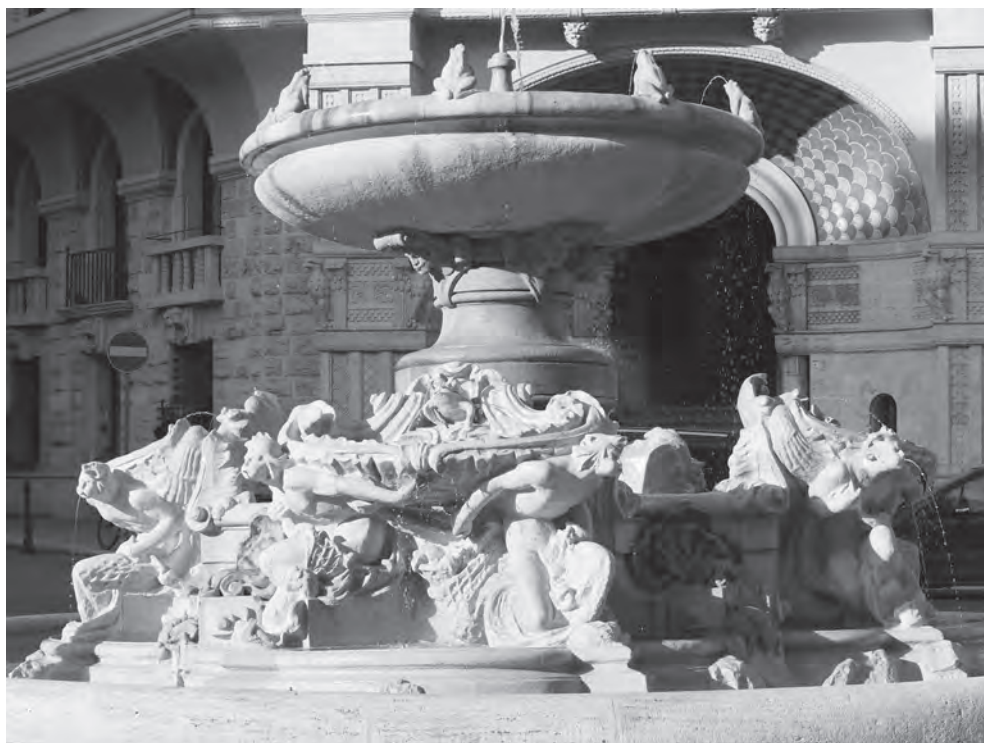
Fig. 7. Roma, fontana delle Rane nel quartiere Coppedè (foto 2021). Lo strato di finitura dell'opera in conglomerato mirava a simulare una creazione in travertino per dare una decisa impronta di 'romanità' come nei basamenti degli edifici che definiscono piazza Mincio, con cui l'opera – ricca di citazioni di fontane storiche romane – dialoga strettamente.
