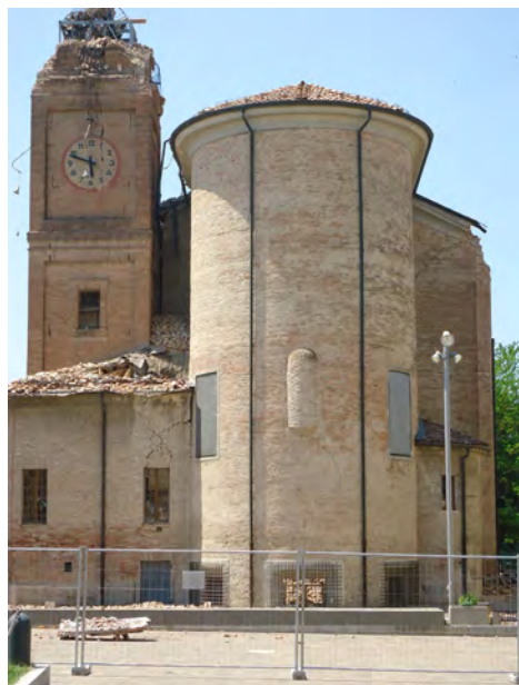
Figg. 3-4. Il prospetto posteriore dopo il sisma. L'abside, molto slanciata, risulta completamente svincolata dai corpi adiacenti, che ne hanno significativamente subito il cinematisimo. A destra, particolare del lato orientale del campanile. È visibile la cerchiatura della parte sommitale mediante fasce di fibre in poliestere.
