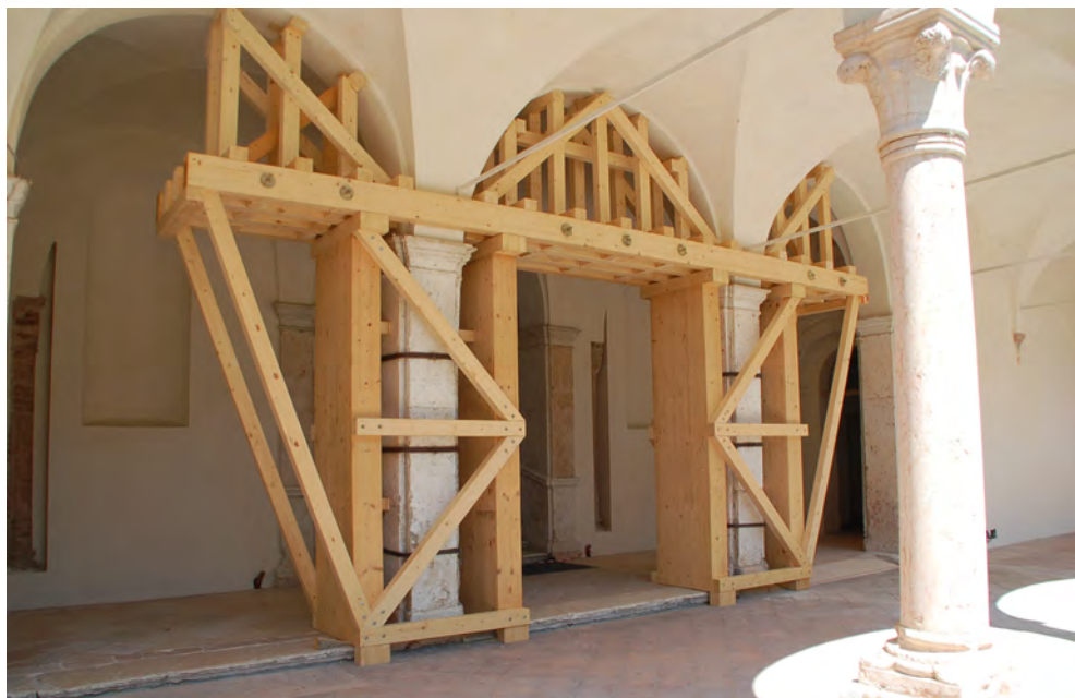
Fig. 6. San Benedetto Po, monastero di S. Benedetto in Polirone: messa in sicurezza dei pilastri e degli archi delle volte nell'androne di ingresso.
