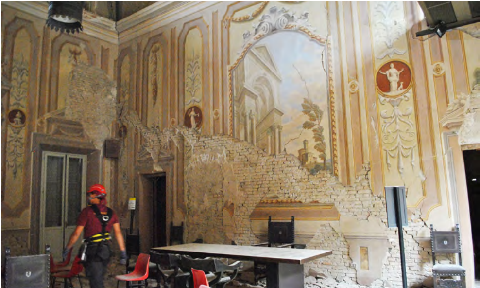
Fig. 4. Dettaglio di uno dei saloni; sono visibili le ampie lacune dell'intonaco dipinto, parzialmente reintegrabili anche mediante il recupero dei frammenti a terra.
