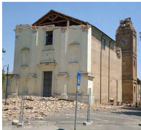
Figg. 1-2. La chiesa prima del sisma. La parte orientale della navata è sovrastata da uno slanciato tiburio ottagonale (foto di N. Pollastri). A destra, il lato sud-occidentale dell'edificio dopo il sisma. La chiesa presenta il consueto meccanismo di ribaltamento della parte superiore della facciata, con il crollo della parte terminale del campanile e dell'intero tiburio.
