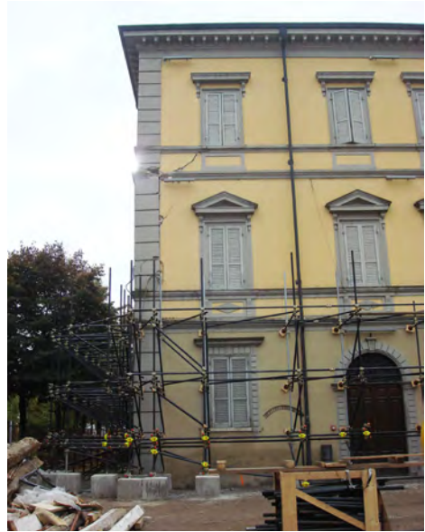
Fig. 2-3. Vista di dettaglio che evidenzia il meccanismo di danno dovuto alla rotazione rigida della parete nord-orientale. Particolare del prospetto dell'edificio. In primo piano è visibile la lesione verticale in corrispondenza della soluzione di continuità originata a seguito delle sopraelevazioni post-unitarie.
