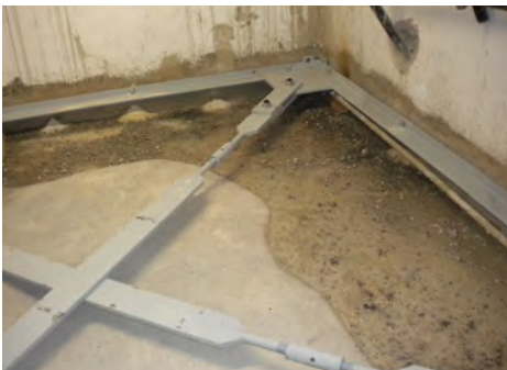
Fig. 4-5. Irrigidimento di piano eseguito con profili e piatti metallici (dicembre 2011). Il restauro di una volta: esempio di reintegrazione di una lacuna decorativa (maggio 2012).
