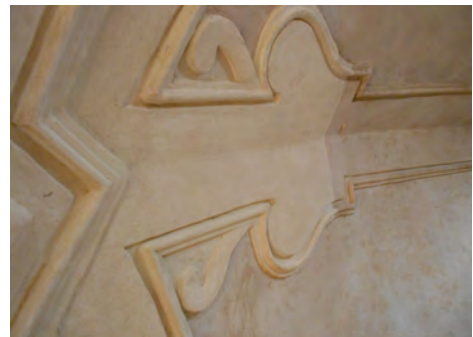
Fig. 4-5. Irrigidimento di piano eseguito con profili e piatti metallici (dicembre 2011). Il restauro di una volta: esempio di reintegrazione di una lacuna decorativa (maggio 2012).
