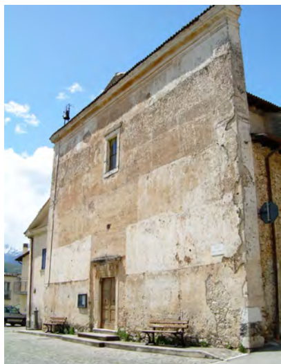
Fig. 2. La facciata prima del sisma (foto 2008).
