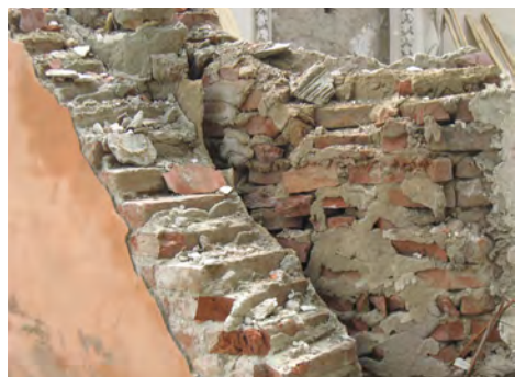
Figg. 2-3. Un dettaglio della muratura del fianco occidentale; la struttura muraria apparecchiata con laterizi disposti prevalentemente di testa agevola la formazione di piani di rottura diagonali. A destra, vista ovest posteriore al sisma (dettaglio), con i consistenti crolli delle murature.
