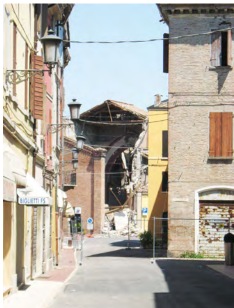
Fig. 3-4. La chiesa, vista da sud-ovest, dopo il sisma. La navata centrale, la navata destra e il campanile appaiono quasi completamente crollati. Rimangono integre la facciata, la navata sinistra e l'abside. A destra, particolare delle operazioni di messa in sicurezza con strutture intelaiate a giunto-tubo che hanno riguardato la sola facciata, rimasta libera su entrambi i fronti.
