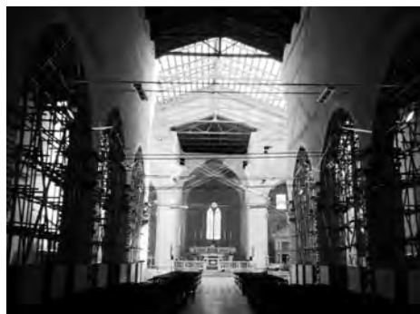
Figg. 4-5. La cappella del Mausoleo Celestiniano, dopo il crollo (agosto 2009). A destra, lo stato attuale della fabbrica. La copertura provvisoria del transetto prosegue lo schema a due falde della navata.
