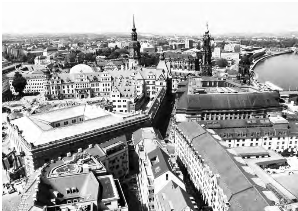
Fig. 1. Dresda, veduta della città dalla cupola della Frauenkirche. Si notano alcune coperture ricostruite a causa delle distruzioni per gli eventi bellici della seconda guerra mondiale e il cortile del Residenzschloss chiuso da una struttura voltata di acciaio e vetro (fotografia D. Concas 2009).
