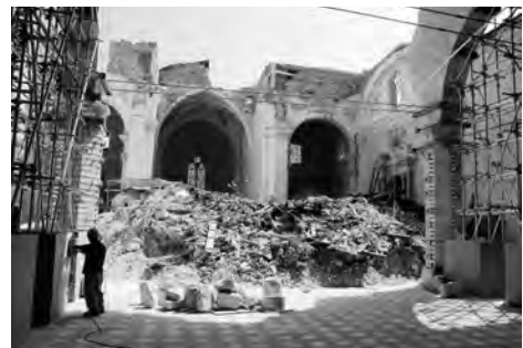
Fig. 2-3. La facciata nello stato attuale. L'interno della basilica, con, in primo piano, le macerie derivanti dal crollo delle volte del transetto (agosto 2009).
