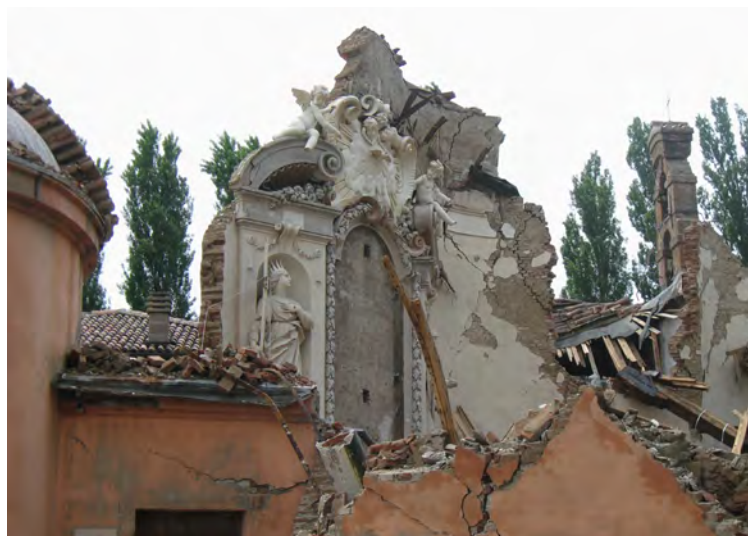
Fig. 4. Dopo il terremoto l'unica porzione rimasta intatta è costituita dall'abside curvilinea recante il pregevole altare maggiore.
