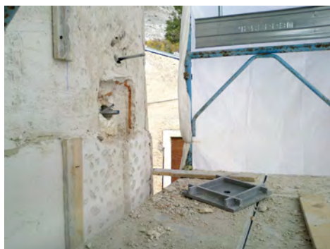
Fig. 4-5. L'intervento sulla volta absidale (foto luglio 2012 di F. Fabrizio). Esempio di messa in opera all'interno del muro perimetrale ortogonale alla facciata di una catena metallica (dotata di calza) ancorata a una piastra quadrata (foto settembre 2012 di F. Fabrizio).
