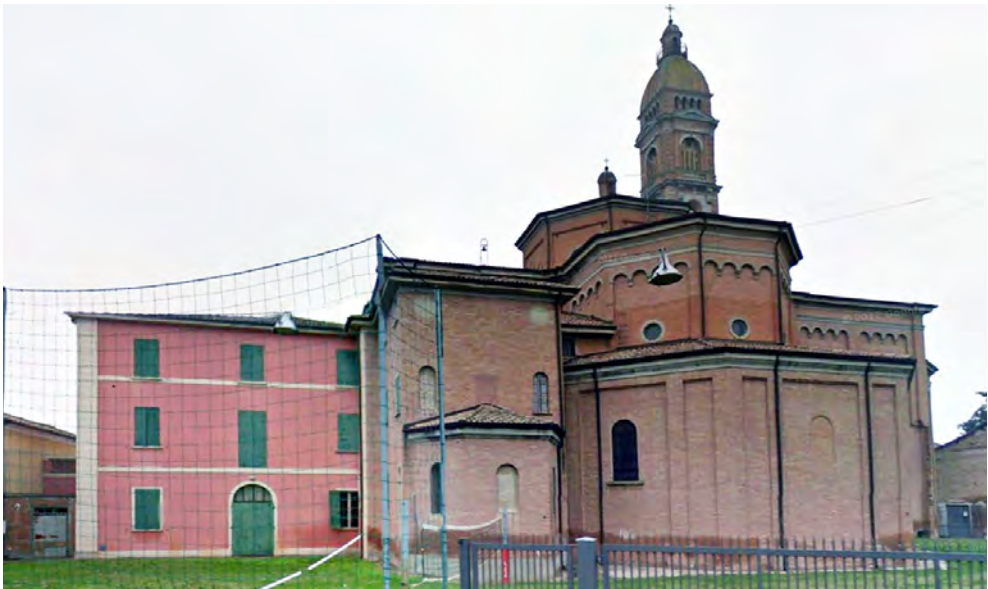
Fig. 1. Il fianco dell'edificio prima del sisma. Si distinguono il transetto asimmetrico limitato a sud dalla presenza della canonica, l'ampio deambulatorio, l'abside emiottagonale e il modesto tiburio (foto Google inc.).
