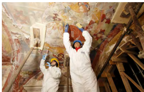
Fig. 3. Il fronte absidale dopo le prime operazioni di messa in sicurezza.
