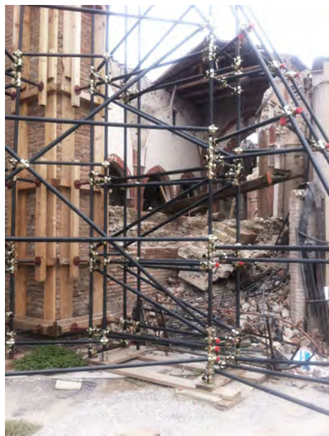
Fig. 3-4. La chiesa, vista da sud-ovest, dopo il sisma. La navata centrale, la navata destra e il campanile appaiono quasi completamente crollati. Rimangono integre la facciata, la navata sinistra e l'abside. A destra, particolare delle operazioni di messa in sicurezza con strutture intelaiate a giunto-tubo che hanno riguardato la sola facciata, rimasta libera su entrambi i fronti.
