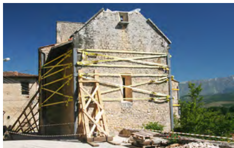
Fig. 3. Il fronte absidale dopo le prime operazioni di messa in sicurezza.
