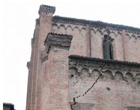
Figg. 1-2. Il complesso prima del sisma: l'intera facciata e parte della parete meridionale sono le sole strutture murarie sopravvissute alle demolizioni volute da Francesco Facci (foto di N. Pollastri). A destra, un dettaglio del lato meridionale della chiesa come si presentava il 21 maggio 2012, tra la prima e la seconda scossa; è visibile il meccanismo di danno determinato dal ribaltamento della facciata.
