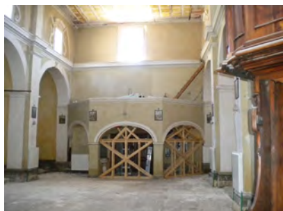
Fig. 3. L'interno della chiesa: l'endonartece dopo le opere di messa in sicurezza realizzate dai Vigili del fuoco (foto 2009).
