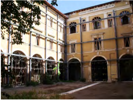
Fig. 2. Veduta dei prospetti interni presso un angolo del portico interno dopo la messa in sicurezza.
