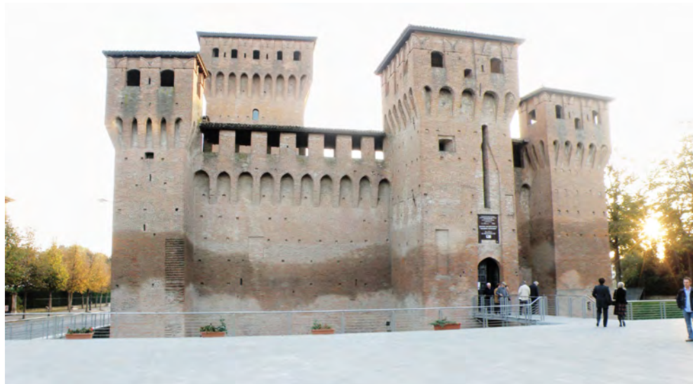
Fig. 1. Il lato settentrionale della rocca prima del sisma; è riscontrabile il vincolo asimmetrico sulle murature delle torri (torri inglobate). Foto da http://www.concretamentesassuolo.it
