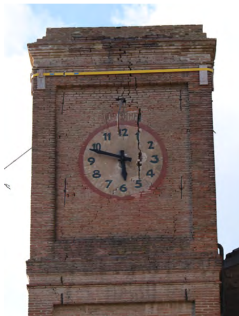
Figg. 3-4. Il prospetto posteriore dopo il sisma. L'abside, molto slanciata, risulta completamente svincolata dai corpi adiacenti, che ne hanno significativamente subito il cinematisimo. A destra, particolare del lato orientale del campanile. È visibile la cerchiatura della parte sommitale mediante fasce di fibre in poliestere.
