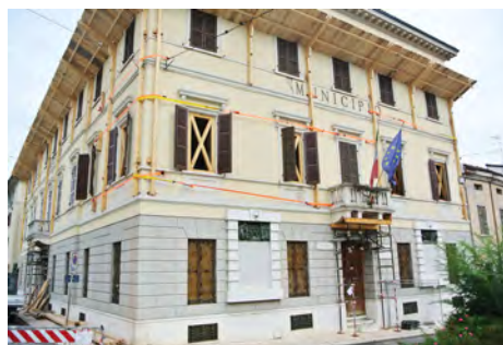
Fig. 8. Quistello, Municipio; messa in sicurezza dell'edificio mediante cerchiatura disposta su più livelli, sbadacchiatura delle aperture, supporti speciali per strutture aggettanti e "mantovana" di protezione del passaggio pubblico in caso di caduta di elementi del cornicione.
