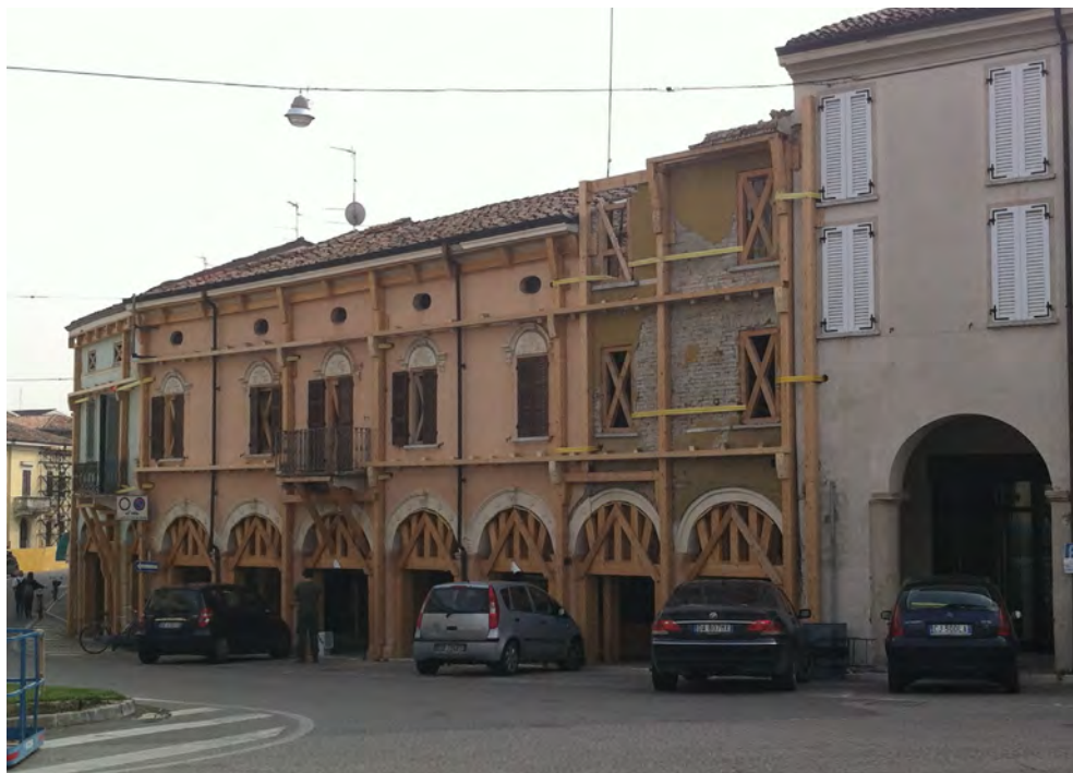
Fig. 2. Quistello, centro storico; opere provvisorie per contrastare il ribaltamento delle facciate, le vulnerabilità dovute alla presenza del portico e alle differenti altezze di edifici accostati, per sostenere le strutture aggettanti dei balconi e dei cornicioni sommitali.
