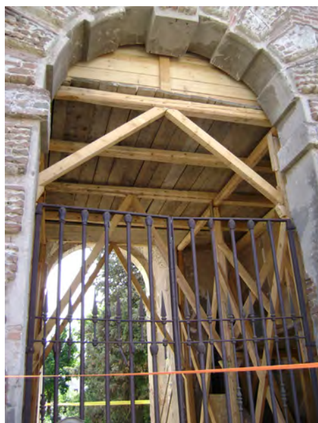
Fig. 3. San Benedetto Po, località Portiolo, palazzo Gonzaga di Vescovato: cerchiature del corpo centrale disposte su tre livelli e messa in sicurezza dei corpi laterali mediante cinghie di nylon e morali lignei verticali.
