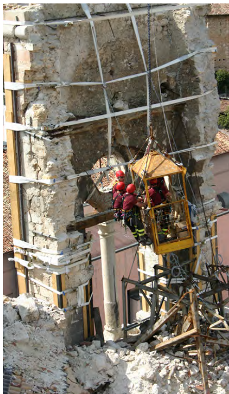
Fig. 3. Le operazioni di messa in sicurezza del campanile dopo il crollo.
