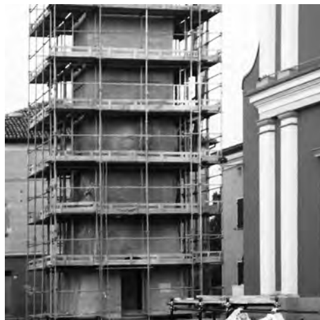
Fig. 4. Reno Centese Di Cento (Ferrara), torre campanaria. La struttura, gravemente lesionata, non è stata demolita ma è stata messa in sicurezza con cospicue iniezioni di malte ad alto potere legante, volte a ridare continuità alla compagine muraria.
