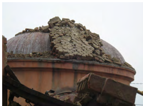
Figg. 2-3. Un dettaglio della muratura del fianco occidentale; la struttura muraria apparecchiata con laterizi disposti prevalentemente di testa agevola la formazione di piani di rottura diagonali. A destra, vista ovest posteriore al sisma (dettaglio), con i consistenti crolli delle murature.
