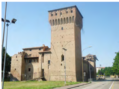
Fig. 2. Il fronte meridionale con il maschio in primo piano; quest'ultimo, proprio a partire da una discontinuità muraria chiaramente individuabile, ha riportato ampie lesioni inclinate, con il parziale scorrimento della struttura.
