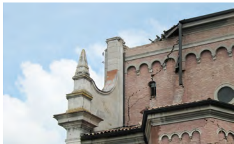
Fig. 2. Un particolare del medesimo fianco dopo il sisma. I crolli hanno interessato il tiburio, l'abside, il deambulatorio, il tratto settentrionale e parte dell'estremità meridionale del transetto.
