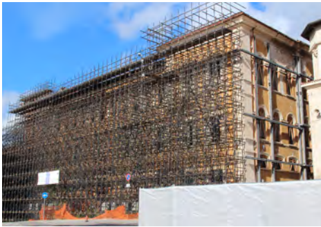
Fig. 3. La facciata principale, su piazza S. Bernardino, dopo l'intervento di messa in sicurezza.
