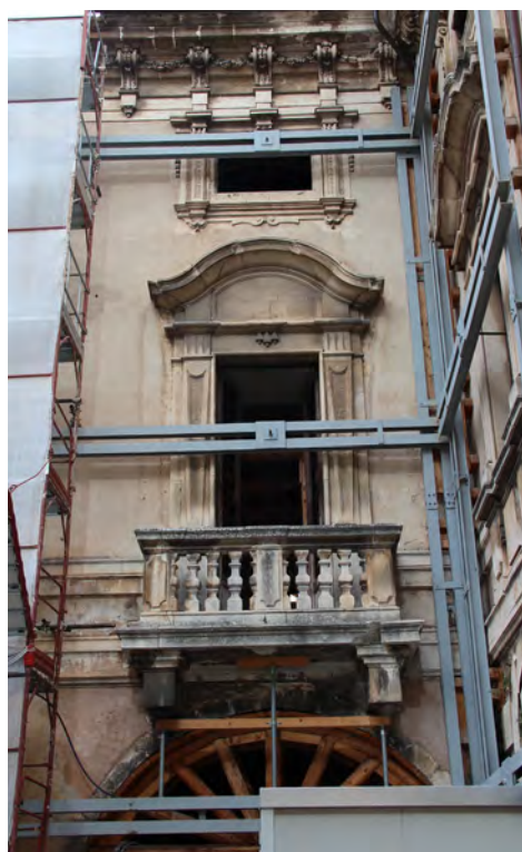
Fig. 4. Particolare della messa in sicurezza dei fronti perimetrali del palazzo.
