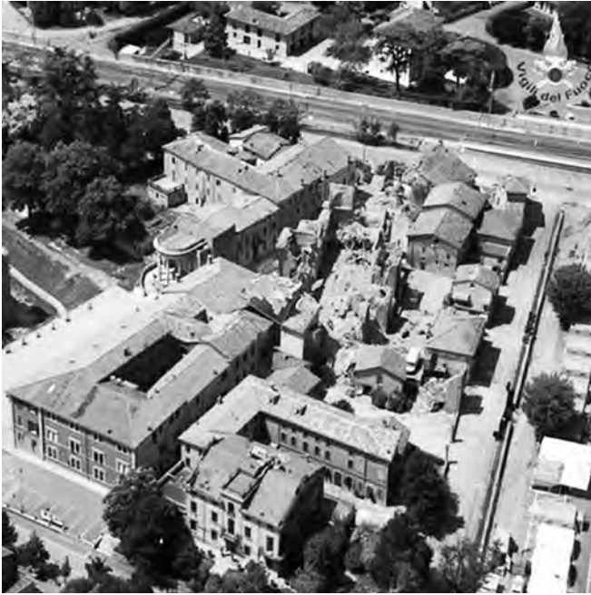
Fig. 8. San Felice sul Panaro (Modena), centro urbano. L'agglomerato risulta gravemente compromesso, mentre la chiesa Arcipretale, situata in posizione centrale, è pressoché completamente crollata. Solo un intervento criticamente condotto, sulla base di approfonditi studi storico-urbanistici, potrà tentare di reintegrare il tessuto edilizio storico.
