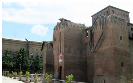
Fig. 3. Il fianco settentrionale dopo il sisma; la rigidità dei cordoli in c.a. e la pesante massa delle coperture hanno provocato il crollo dei coronamenti delle torri più piccole.
