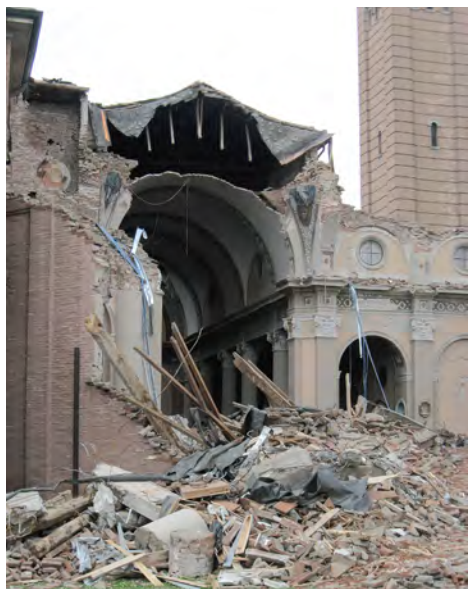
Fig. 2. Un particolare del medesimo fianco dopo il sisma. I crolli hanno interessato il tiburio, l'abside, il deambulatorio, il tratto settentrionale e parte dell'estremità meridionale del transetto.
