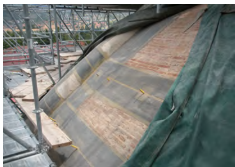
Fig. 4. Particolare dell'esterno della cupola dopo le operazioni di consolidamento dell'estradosso.
