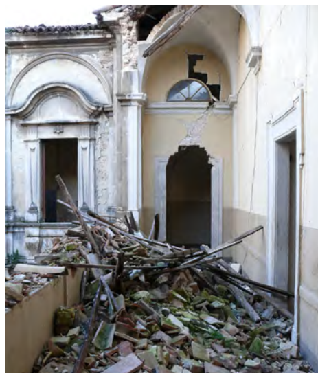
Fig. 2-3. Particolare di un ambiente interno dopo il sisma del 2009. I crolli del fronte sul cortile interno.
