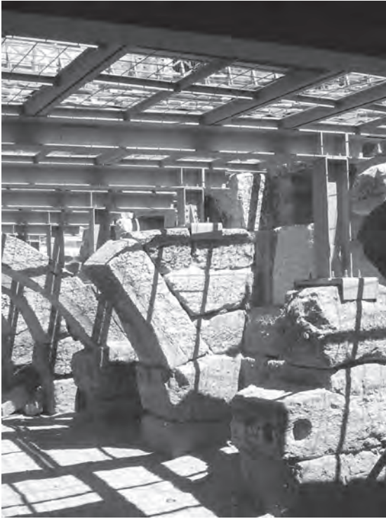
Fig. 4. Hierapolis, particolare della nuova pedana scenica del teatro che appoggia sulle antiche strutture architettoniche.
