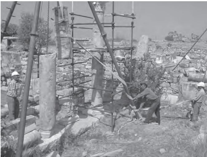
Fig. 10. Hierapolis, il battistero durante i lavori di anastilosi delle colonne; i fusti sono spolia provenienti, verosimilmente, dal Ninfeo dei Tritoni.
