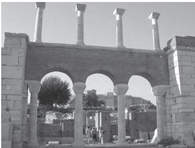
Fig. 11. Efeso, uno degli ambienti della basilica di S. Giovanni: sono evidenti i restauri di integrazione, iniziati nei primi decenni del secolo scorso.
