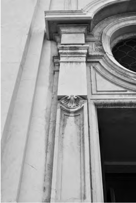
Fig. 4. Chiesa di Santa Maria in Piazza, dettaglio del fronte meridionale. Depositi e croste nere in corrispondenza degli aggetti e degli elementi scultorei maggiormente articolati.
