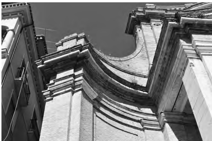
Fig. 6. Chiesa del Gesù. A poca distanza dal restauro la vegetazione invasiva è nuovamente presente all'estradosso delle volute e delle cornici. Nelle zone protette dal dilavamento si osserva già l'incipiente sviluppo delle croste nere.
