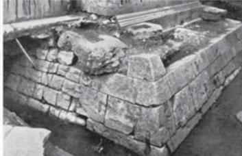
(1880-1956), sono stati eseguiti degli scavi atti a portare in luce le originarie fondazioni (fig. 3), che hanno raggiunto la quota del fondo sabbioso sommerso dall'acqua del mare. La fondazione a pianta ottagona è risultata formata perlopiù da blocchi di duro calcare del Conero disposti a scarpa e giuntati tra loro con malta pozzolanica; i laterali, eseguiti con blocchi più piccoli con riprese di laterizi, rivelano invece una fattezza più economica. Ciò testi-
