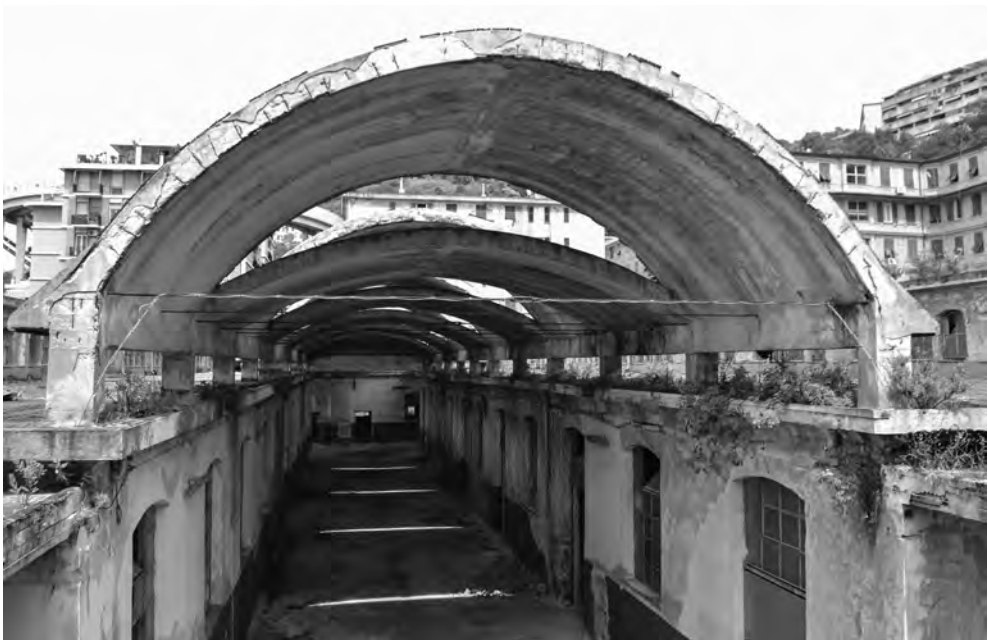
Fig. 4. Genova-Campasso, ex-mattatoio, volte sottili in laterizio armato tipo Bisap aggiunte a metà Novecento a copertura delle strade interne e demolite nell'ambito del progetto di riuso del complesso. Analogamente è stato demolito il padiglione che si vede a sinistra nell'immagine mentre sarà conservato il padiglione di destra (foto C. Moggia 2017).
