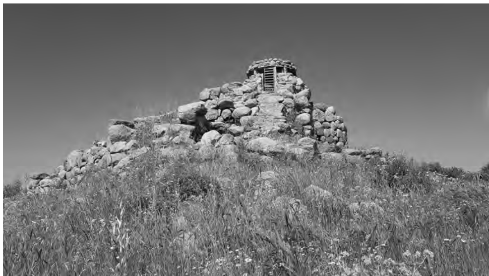
Fig. 6. Quartu Sant'Elena (CA), località Is Mortorius, Batteria Carlo Faldi presso Nuraghe Diana, tecnica di mimetizzazione della postazione militare sui resti archeologici.
