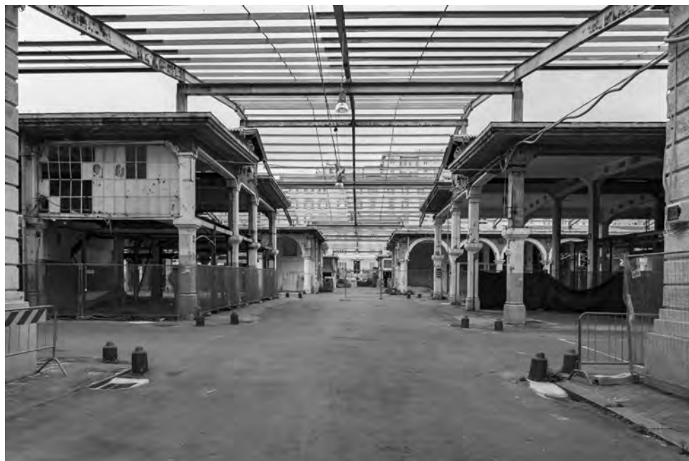
Fig. 5. Genova-Marassi, ex-mercato generale della frutta e della verdura, l'ingresso del mercato prima della demolizione dei padiglioni (foto M. Ridella 2018).
