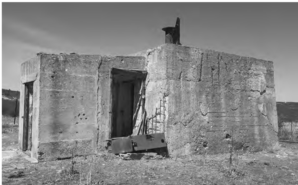
Fig. 10. Perdasdefogu (NU), PISQ, Torre Gigli, manufatto in calcestruzzo armato per il controllo delle sperimentazioni di lancio.
