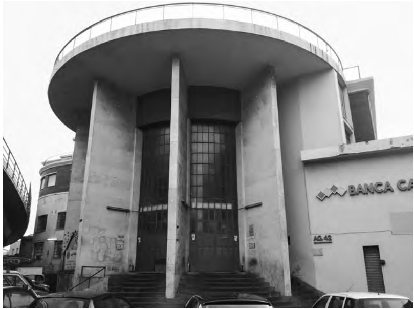
Fig. 7. Genova, ex-mercato del pesce al Molo, l'ingresso principale con i setti in c.a. rivestiti in pietra di Finale e disposti a raggiera, in una foto del 2012 (CAFFERATA et al. 2022).
