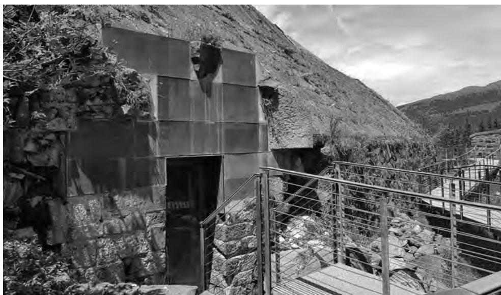
Fig. 4. Predazzo, località Paneveggio (TN), forte Dossaccio, particolare dell'integrazione della lacuna realizzata nell'ambito dell'intervento di restauro e valorizzazione, incluso nel "Progetto Grande Guerra".
