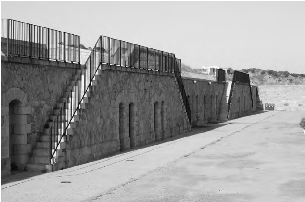
Fig. 2. Caprera, forte Arbuticci, particolare dell'accesso alle riservette e alle postazioni in barbetta degli obici.
