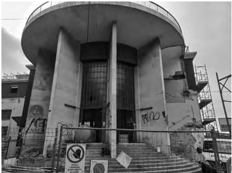
Fig. 8. Genova, ex-mercato del pesce al Molo, i lavori in corso che hanno demolito il volume del 1972 a destra dell'ingresso principale, in una foto del 2022 (CAFFERATA et al. 2022).
