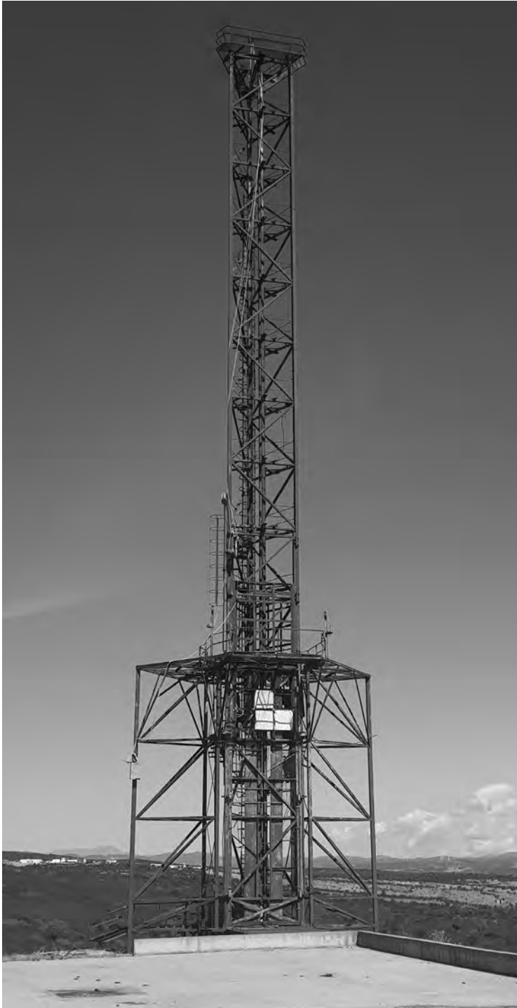
Fig. 9. Perdasdefogu (NU), PISQ, Torre Gigli, dettaglio della struttura in ferro.
