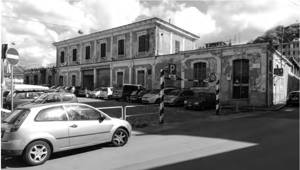
Fig. 3. Genova-Campasso, ex-mattatoio, padiglione di testa dei primi del Novecento, in muratura portante con solai in laterocemento, conservato nel progetto di riuso del complesso (foto R. Vecchiattini 2017).
