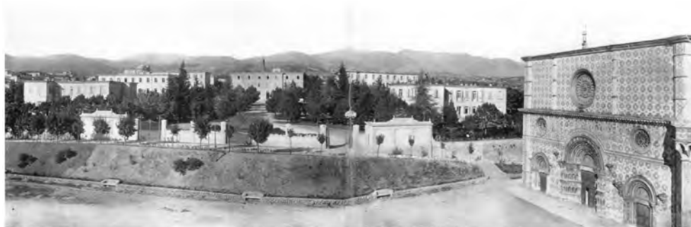
Fig. 8. La foto storica mostra il sito in cui fu costruito nei primi anni del novecento l'ospedale psichiatrico, accanto alla basilica di Collemaggio (da BENVENUTI 1942). Oggi il complesso, nascosto da una fitta vegetazione, è trascurato e soggetto a potenziali speculazioni; diversi edifici sono stati realizzati dopo l'abolizione del manicomio e molte costruzioni provvisorie occupano dal 2009 gli spazi liberi dell'originario giardino.
