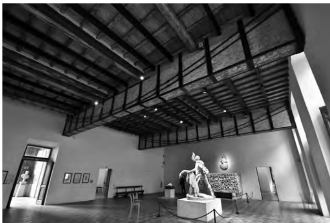
Fig. 6. Palazzo Altemps. Il salone del Galata suicida , dopo il restauro delle strutture di orizzontamento (foto R. Nadalin 2019).
