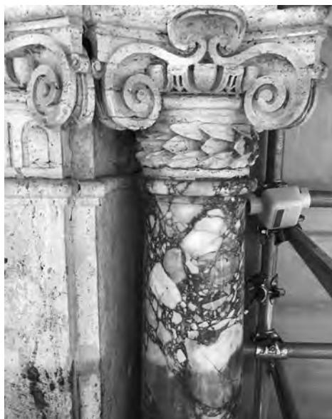
Fig. 5. Palazzo Doria Pamphilj, prospetto su via del Corso: tassello di pulitura sul travertino e sulla colonnina in breccia marmorea del primo balcone di sinistra. Foto S. Sarmati, su gentile concessione Trust Doria Pamphilj.
