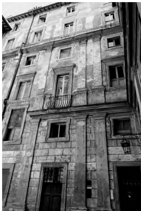
Fig. 2. Il fronte est del cortile prima del restauro. Foto Aurea Sectio.
