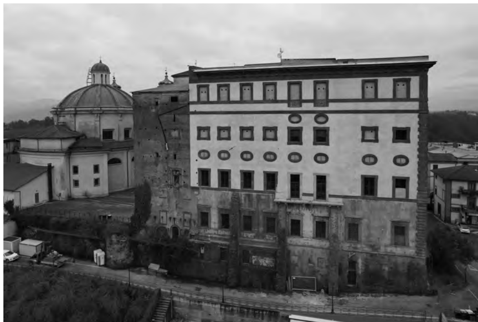
Fig. 14. Facciata lungo la valle del Casaleno dopo l'intervento di restauro.
