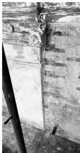
Fig. 5. Dettaglio della finta cortina dipinta in rosa e rosso scuro: disegno 'a pettine' ai lati delle paraste ioniche del piano nobile rimessa in luce con il cantiere. Foto Aurea Sectio.
