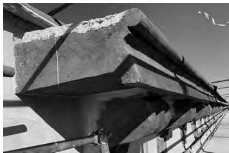
Fig. 2. Ricostruzione della parte terminale del cornicione con i nuovi elementi in EPS ancorati con barre in resina epossidica alla struttura muraria e successivamente trattati con malta strutturale resinosa precolorata data a spruzzo, successivamente tinteggiata e velata color tufo.
