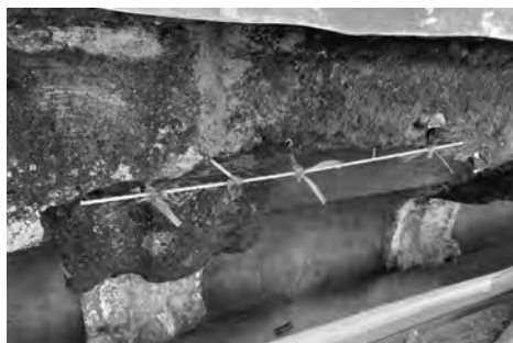
Fig. 3. Stato di fatto del lembo/gocciolatoio del cornicione in cui è evidente lo stato di degrado che si sviluppa per l'intera lunghezza della facciata. L'immagine rappresenta la prima fase dell'intervento che mostra l'inserimento di barre in vetroresina legate con fasce in polipropilene.
