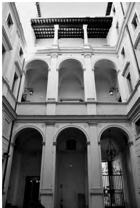
Fig. 1. Roma, palazzo Stati Cenci Maccarani, il cortile dopo il restauro: fronte del loggiato verso l'ingresso. Foto Aurea Sectio.
