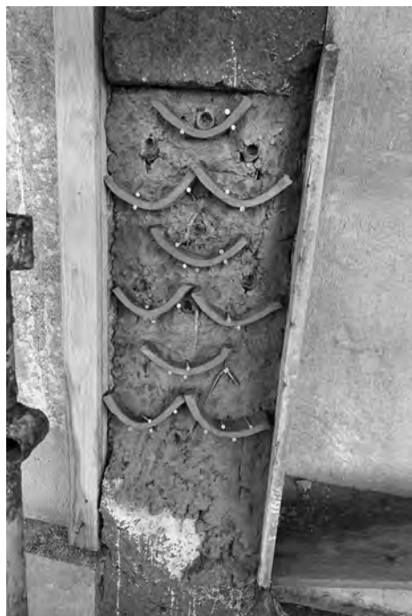
Fig. 12. Esempio di ricostruzione di una cornice di apertura ellittica quasi interamente perduta. Fase finale completa di velatura in cui sono state riproposte le tracce dei telai in legno e delle grate dipinte all'interno delle finestre tamponate.
