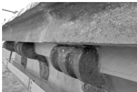
Fig. 4. Reintegrazione delle lacune del lembo/gocciolatoio con malta idraulica a base di pozzolana non vagliata di varia granulometria, lapillo vulcanico, cocciopesto e grassello stagionato successivamente velata color tufo.
