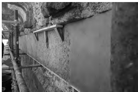
Fig. 6. Realizzazione del nuovo intonaco secondo la stratigrafia originaria.
