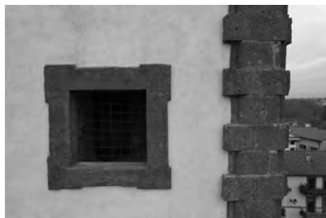
Fig. 10. Ricomposizione dell'architrave in tufo. Stato finale.
