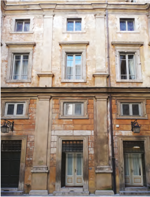
Tav. II. Il fronte sud del cortile prima del restauro. Foto Aurea Sectio.
