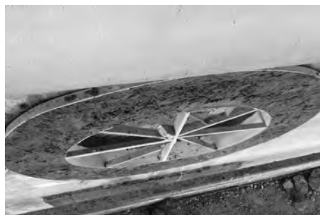
Fig. 11. Esempio di ricostruzione di una cornice di apertura ellittica quasi interamente perduta. Fase di realizzazione di cassature lignee necessarie a contenere l'impasto di malta.
