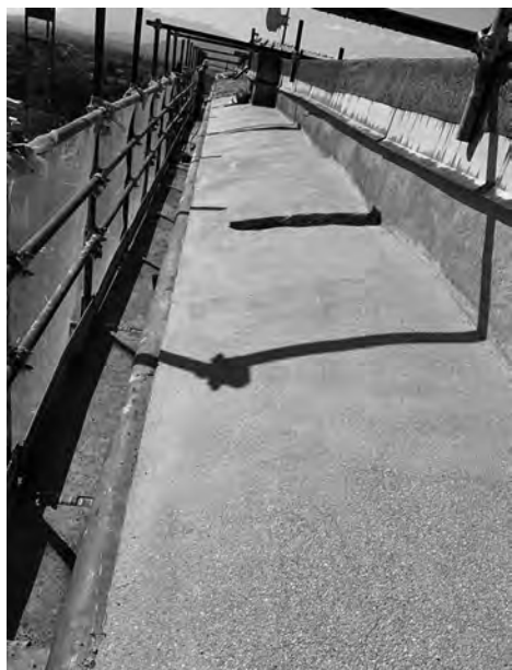
Fig. 5. Nuova impermeabilizzazione del cornicione attraverso l'ancoraggio di una lamina in piombo e la successiva stesura di uno strato di malta a base di cocchiopesto.
