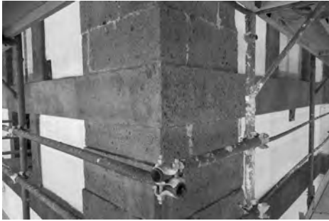
Fig. 8. Stato finale del bugnato consolidato e velato.
