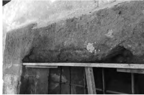
Fig. 9. Lacuna tipo di un architrave in tufo.
