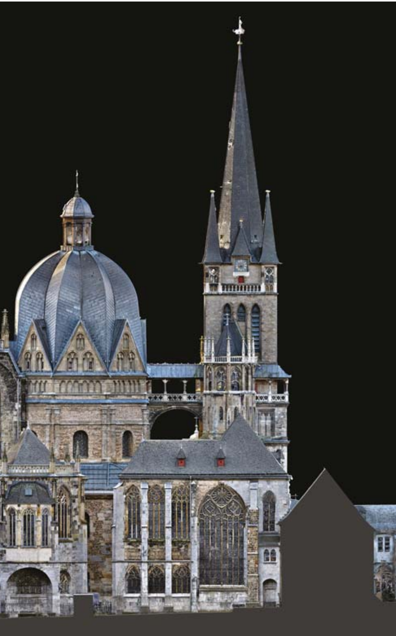
3/ Prospetto sud della Cattedrale di Aachen. Visualizzazione del modello poligonale (elaborazione a cura di Douglas Pritchard). South elevation of Aachen Cathedral. Visualization of the polygonal model (elaborated by Douglas Pritchard).
