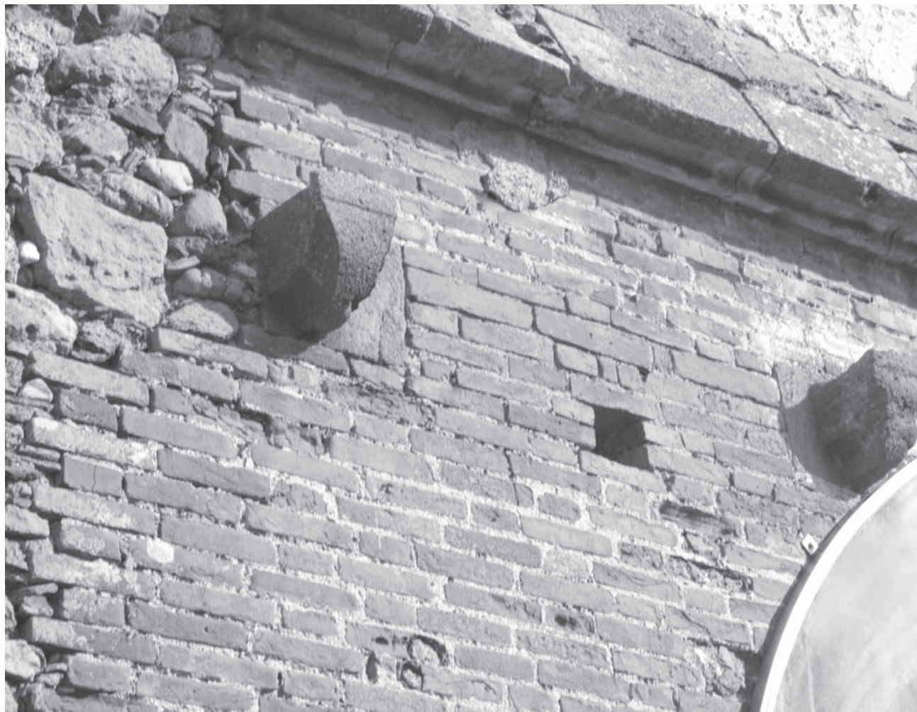
Fig. 22 – San Marco Argentano, abbazia di Santa Maria della Matina, dettaglio delle mensole esterne con soprastante gocciolatoio (foto dell'autore).
