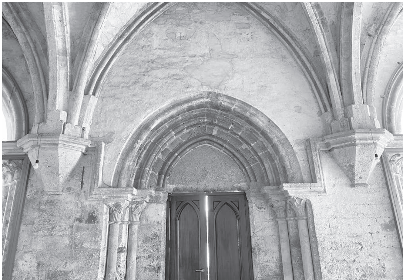
Fig. 20 – San Marco Argentano, abbazia di Santa Maria della Matina, lato interno del portale d'accesso all'aula capitolare; si noti la particolare fattura delle imposte delle volte traccia delle complesse vicende edilizie della fabbrica (foto dell'autore).
