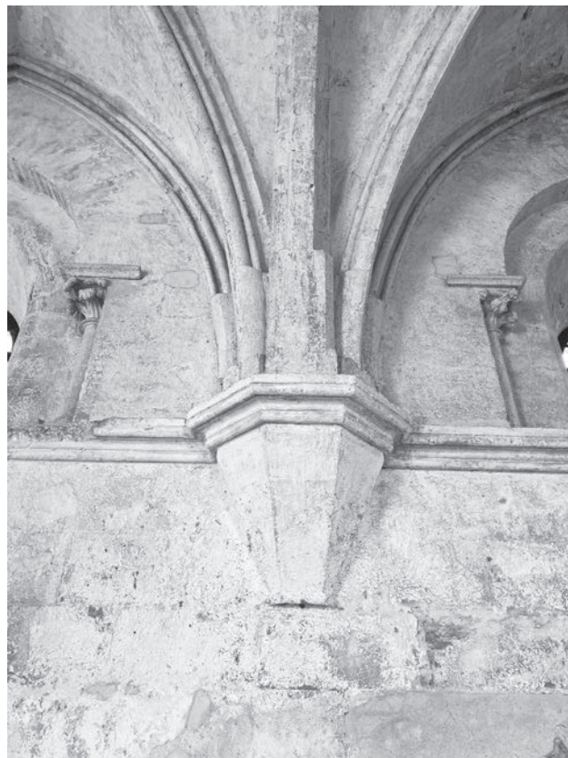
Fig. 15 – San Marco Argentano, abbazia di Santa Maria della Matina, imposte e peducio delle volte tra le prime due finestre di nord-est (foto dell'autore).
