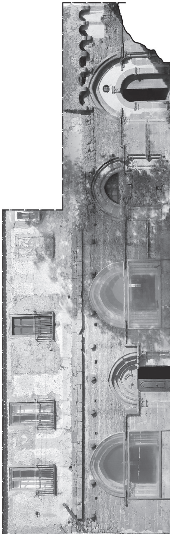
Fig. 3 – San Marco Argentano, abbazia di Santa Maria della Matina, fotopiano della parete sud-ovest (rilievo dell'autore).
