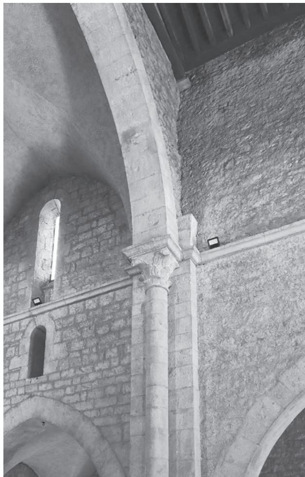
Fig. 19 – Amaseno, Santa Maria Assunta: pilastro n. 9, concio all'imposta della volta della navata centrale incompiuta, particolore (foto di E. Gallotta).
