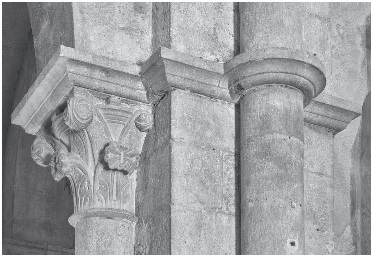
Fig. 10 – Amaseno, Santa Maria Assunta: pilastro n. 4, particolare della cornice all'imposta delle arcate del diaframma (foto di G. Villa).
