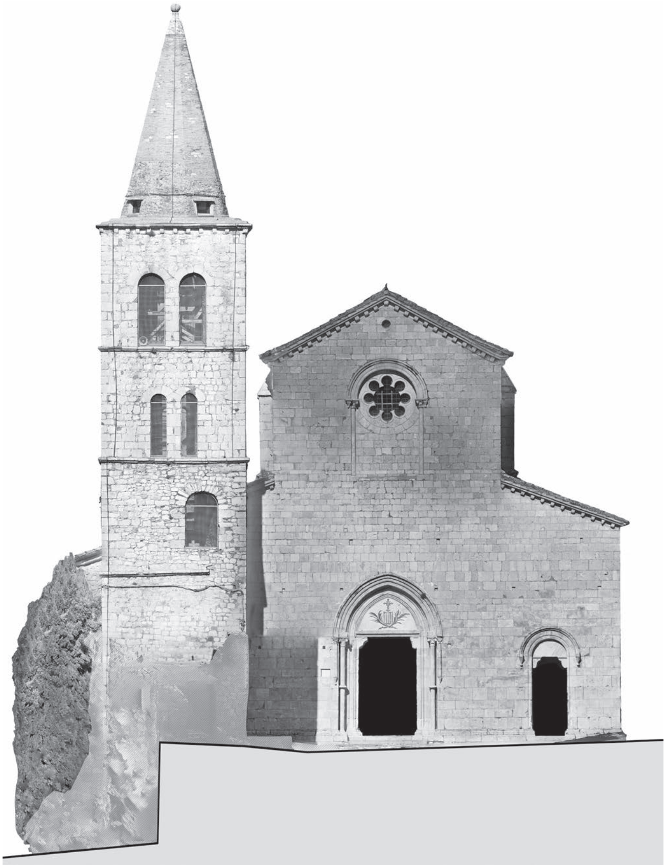
Fig. 8 – Amaseno, Santa Maria Assunta: facciata. Ortofoto ottenuta integrando i dati forniti da Scanner Laser 3D a differenza di fase Faro Focus 3D con quelli ricavati mediante fotogrammetria digitale (elaborazione grafica di R. Barni).
