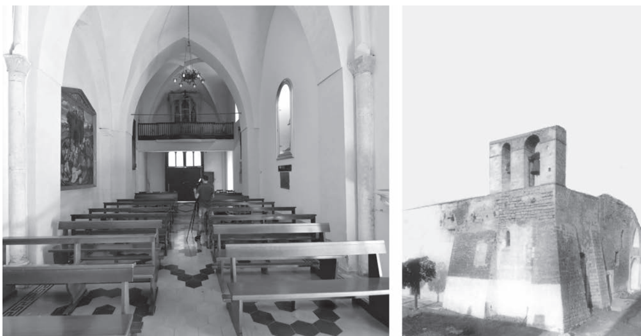
Fig. 9 – Manfredonia, San Francesco. A sinistra, veduta interna verso l'entrata odierna (foto Antonello D'Ardes); a destra foto dell'esterno prima dei restauri (Archivio privato).
