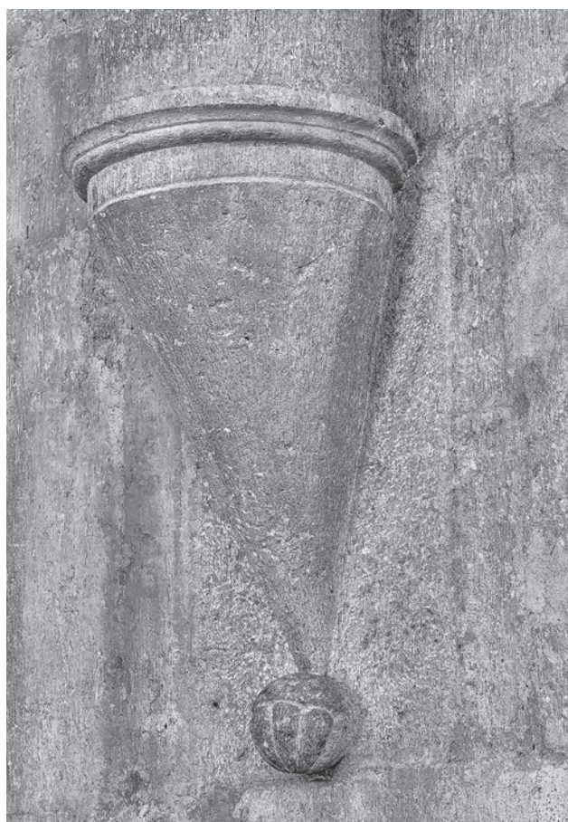
Fig. 13 – Amaseno, Santa Maria Assunta: pilastro n. 8, peduccio conico (foto di G. Villa).
