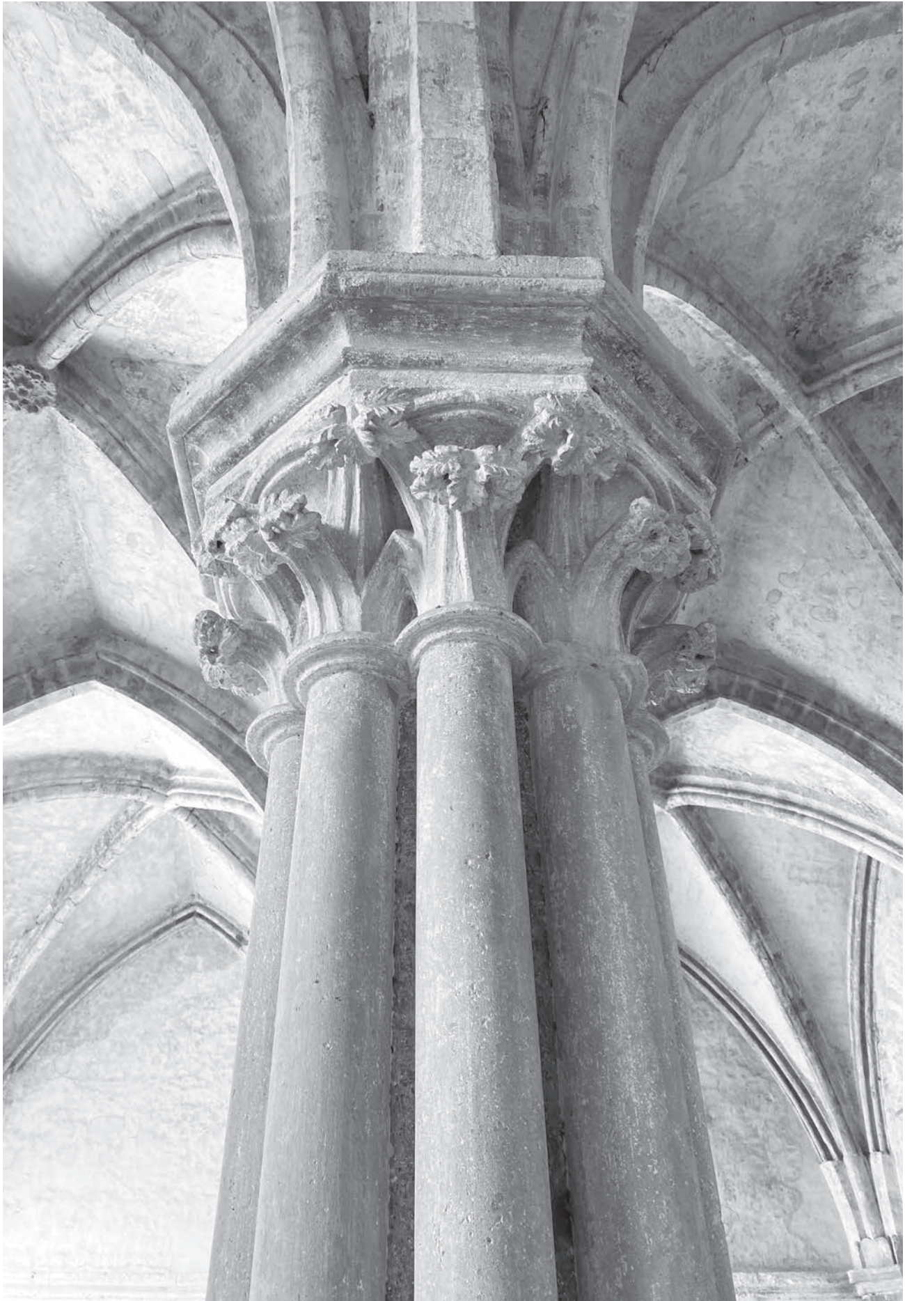
Fig. 12 – San Marco Argentano, abbazia di Santa Maria della Matina, capitello e modanature del pilastro sud-est e nervature delle volte (foto dell'autore).
