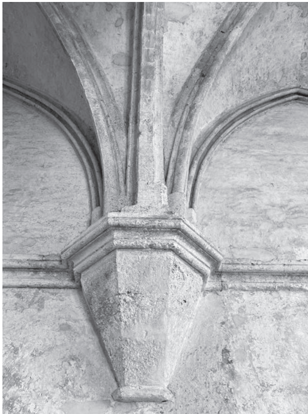
Fig. 21 – San Marco Argentano, abbazia di Santa Maria della Matina, dettaglio del peduccio collocato al centro della parete sud-est che evidenzia l'inusuale conformazione delle imposte delle volte (foto dell'autore).
