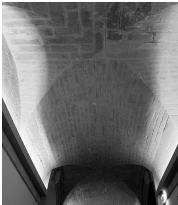
Fig. 9 – La Valletta, collegio gesuitico, volta a crociera su un corridoio in cui si riconoscono i due sistemi impiegati per l'esecuzione degli spigoli, cioè l'accostamento di conci sottili e l'impiego di speciali conci a V (foto di Franceen Galea).
