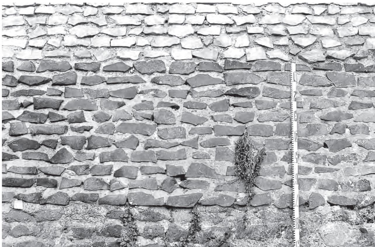
Fig. 3 – Roma, Torre dei Conti: particolare del paramento bicromo in scaglie di lava leucitica e calcari, travertini e marmi di reimpiego a corsi orizzontali (primi anni XIII secolo) (foto D. Esposito)
