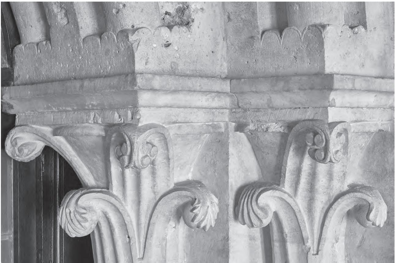
Fig. 29 – Casamari, capitelli nello stipite destro nella bifora della sala capitolare posta a destra del portale di accesso, particolare da cui si evincono le modalità di esecuzione e montaggio dell'abaco (foto dell'autore).
