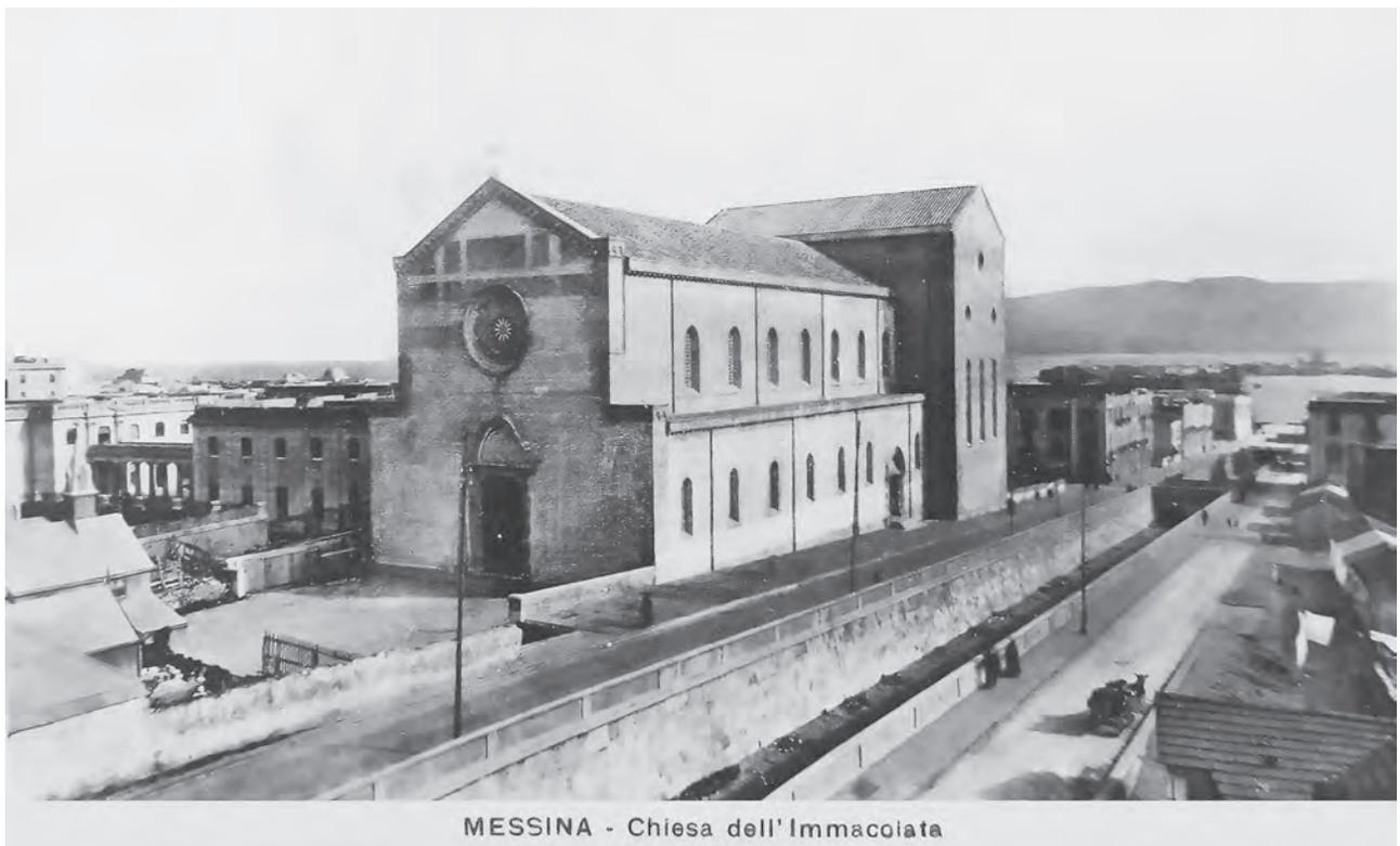
Fig. 4 – Messina, chiesa di S. Francesco all'Immacolata. L'edificio ricostruito in cemento armato dall'arch. Valenti e dagli ingg. Marino e Savoia tra il 1926 e il 1928 (ASCMe, inv. n. 2606, coll. CAR D 22). Veduta con il letto del torrente Bocchetta ancora a cielo aperto.
