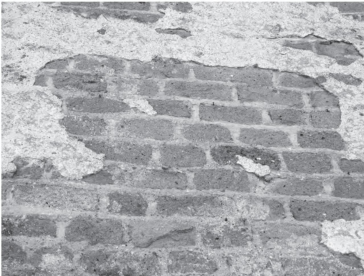
Fig. 6 – Roma, Complesso di Capo di Bove sulla via Appia antica, palazzo: particolare della finitura dei giunti 'a nastro' (fine XIII secolo-inizi XIV secolo) (foto D. Esposito)
