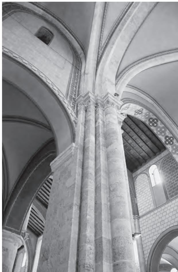
Fig. 11 – Anagni, cattedrale: pilastro a fascio del transetto (foto dell'autore).
