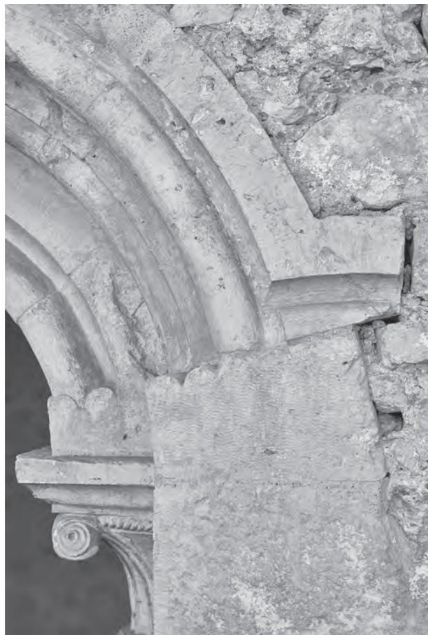
Fig. 22 – Casamari, particolare dell'appoggio della ghiera superiore nella bifora del chiostro S.03 (foto dell'autore).
