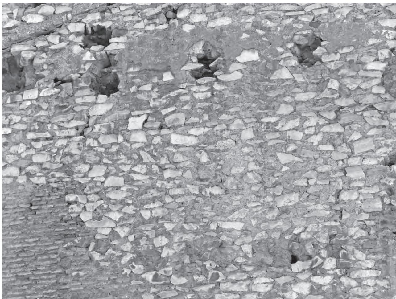
Fig. 1 – Roma, Torre presso il Teatro di Marcello con paramento in bozze e scaglie calcaree a corsi irregolari (XI secolo) (foto D. Esposito)
