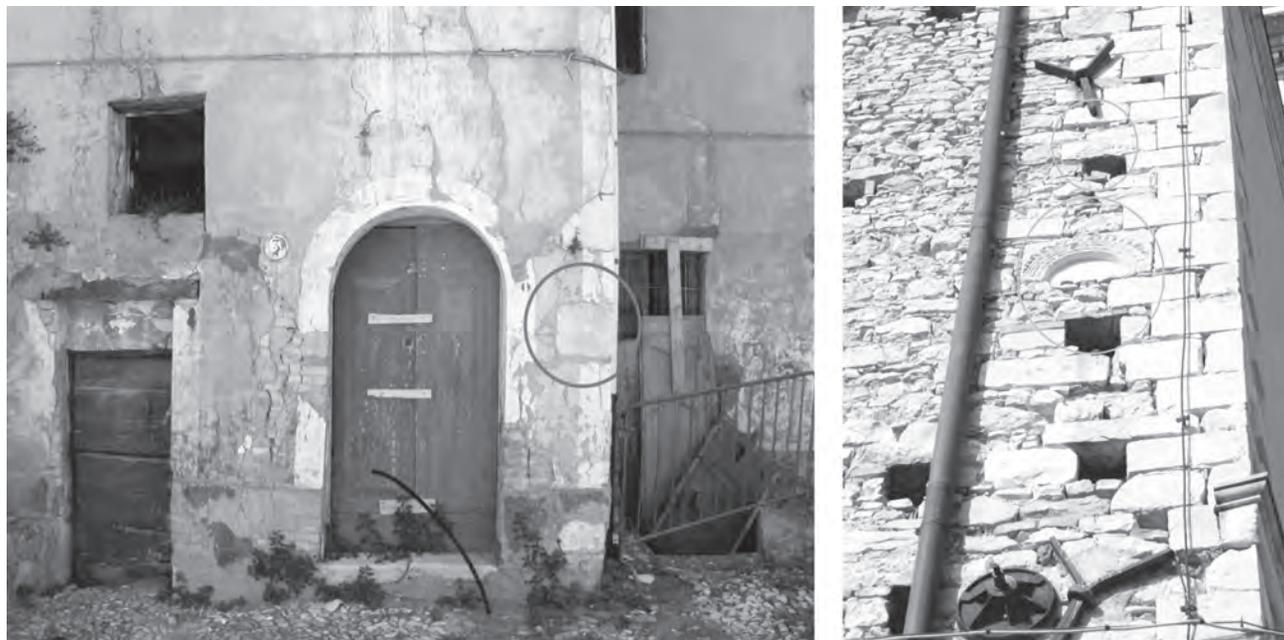
Fig. 3 – Casoli (Ch), La prassi del reimpiego di pezzi «speciale» è testimoniata dai fronti principali di molti edifici del centro frentano, tessuti con conci accuratamente squadrati, architravi, stipiti e cornici (foto dell'autrice).
