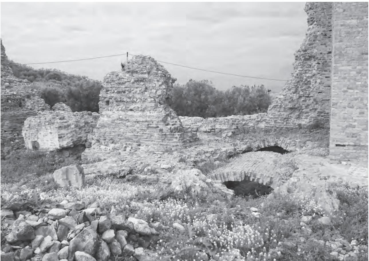
Fig. 9 – Roccelletta di Borgia, Santa Maria della Roccella, veduta dell'area del transetto da sudest. Si riconoscono gli estradossi delle volte della cripta (a destra) e il pilastro d'incrocio nordest (foto dell'autrice).
