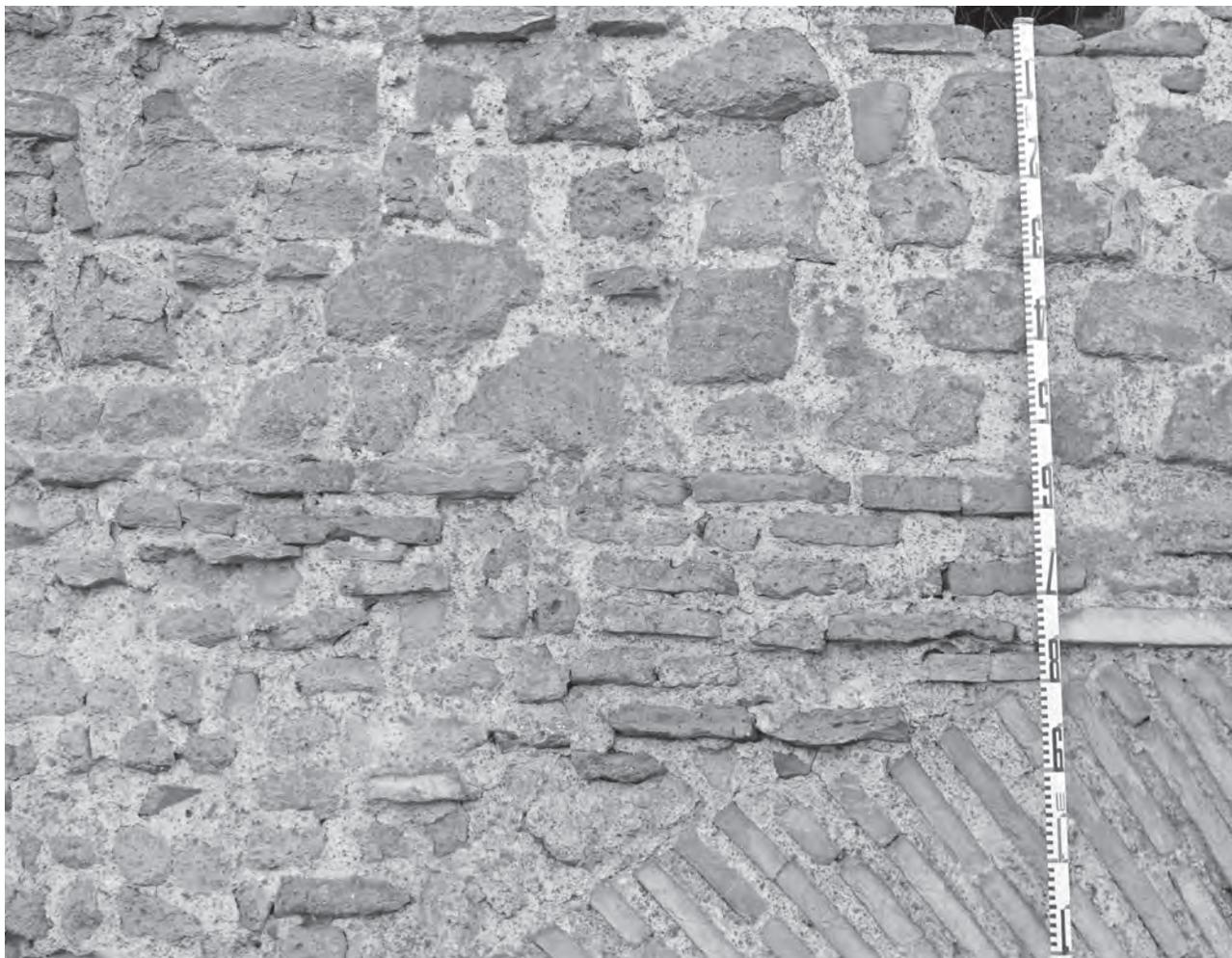
Fig. 2 – Roma, tratto di mura urbane realizzato nel 1157 presso la porta Metronia: particolare del paramento in bozzette di tufo e laterizi di reimpiego (foto D. Esposito)
