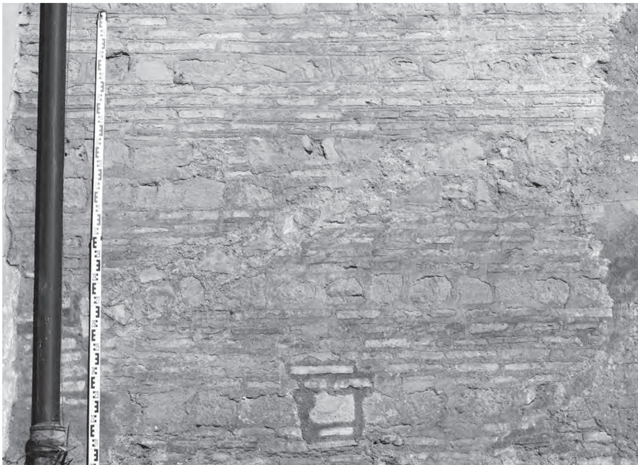
Fig. 7 – Roma, Basilica di San Clemente: paramento della muratura del prospetto laterale (XII secolo) (foto S. Cirulli)
