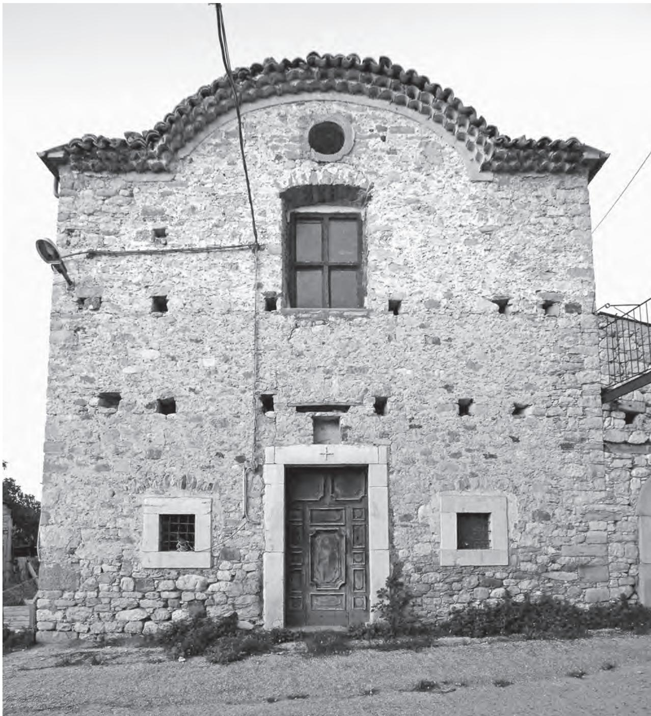
Fig. 4 – Bomba (Ch), Chiesa di Sant'Antonio al Ponte, prospetto principale con apparecchio murario in bozze di calcare e arenaria (foto dell'autrice).
