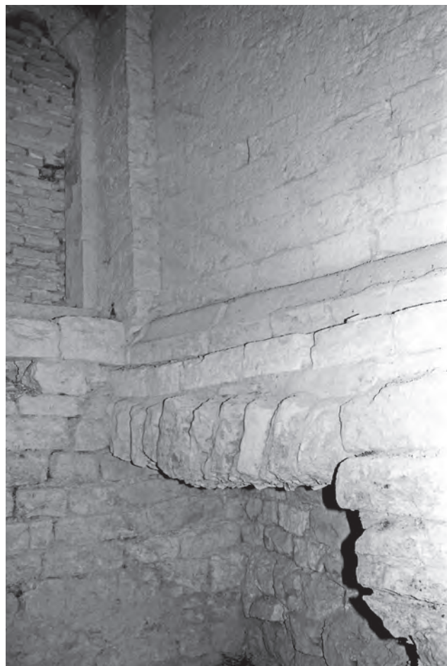
Fig. 12 – Assisi, complesso conventuale di San Francesco, ambiente sottostante la Loggia delle Benedizioni, compreso fra la piazza superiore e l'atrio d'ingresso della basilica inferiore. Si notano la porticina che immetteva al sottotetto dell'atrio d'ingresso alla basilica inferiore (poi tamponata con la costruzione della volta con imposta più alta e la realizzazione della basilica superiore), la cornice in basso che raccorda lo spiccato della parete che poggia sul banco roccioso, il paramento in bozze di pietra calcarea bianca e rosa poco rifinito che corrisponde al risvolto della Loggia delle Benedizioni (foto dell'autrice, 1999).
