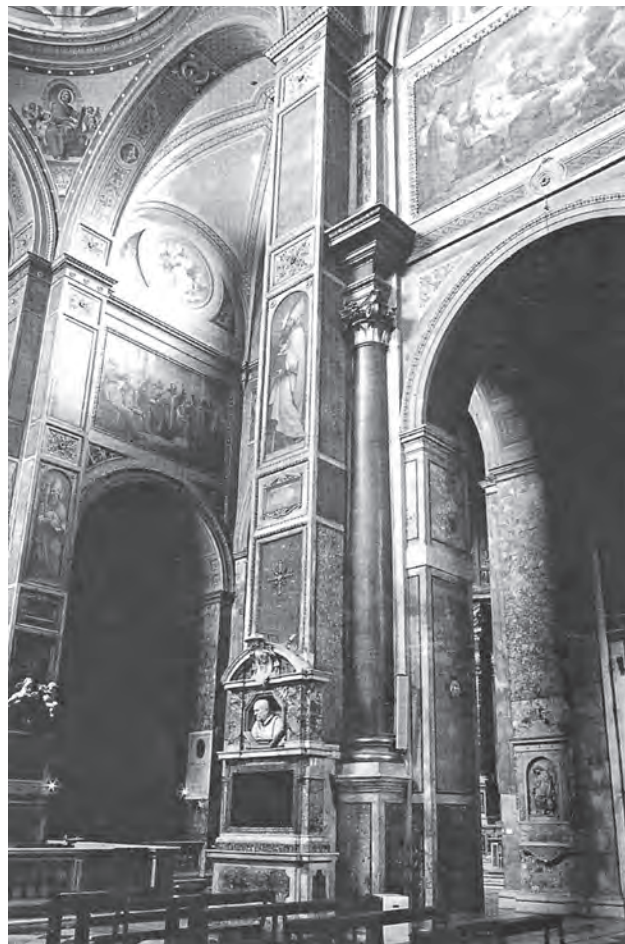
Fig. 9 – Roma, Sant'Agostino, particolare del pilastro all'attacco tra navata centrale e vano della cupola (foto di Lorenzo Dall'Olio).
