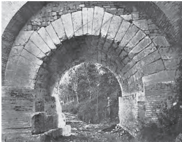
Fig. 6 – Santarcangelo di Romagna, Ponte di pietra sul fiume Uso, veduta di un'arcata (da MANSUELLI 1941, tav. XVI).
