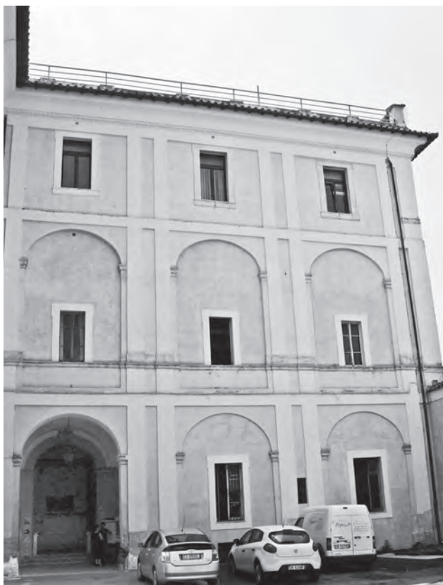
Fig. 6 – Monterotondo, palazzo Comunale, il fronte est della corte principale, allo stato attuale (foto dell'autrice).
