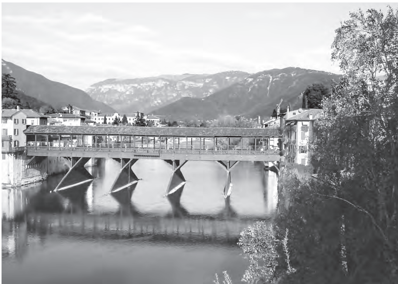
Fig. 8 – Bassano, Ponte Vecchio, vista a restauri ultimati, novembre 2005 (foto Comune di Bassano del Grappa).
