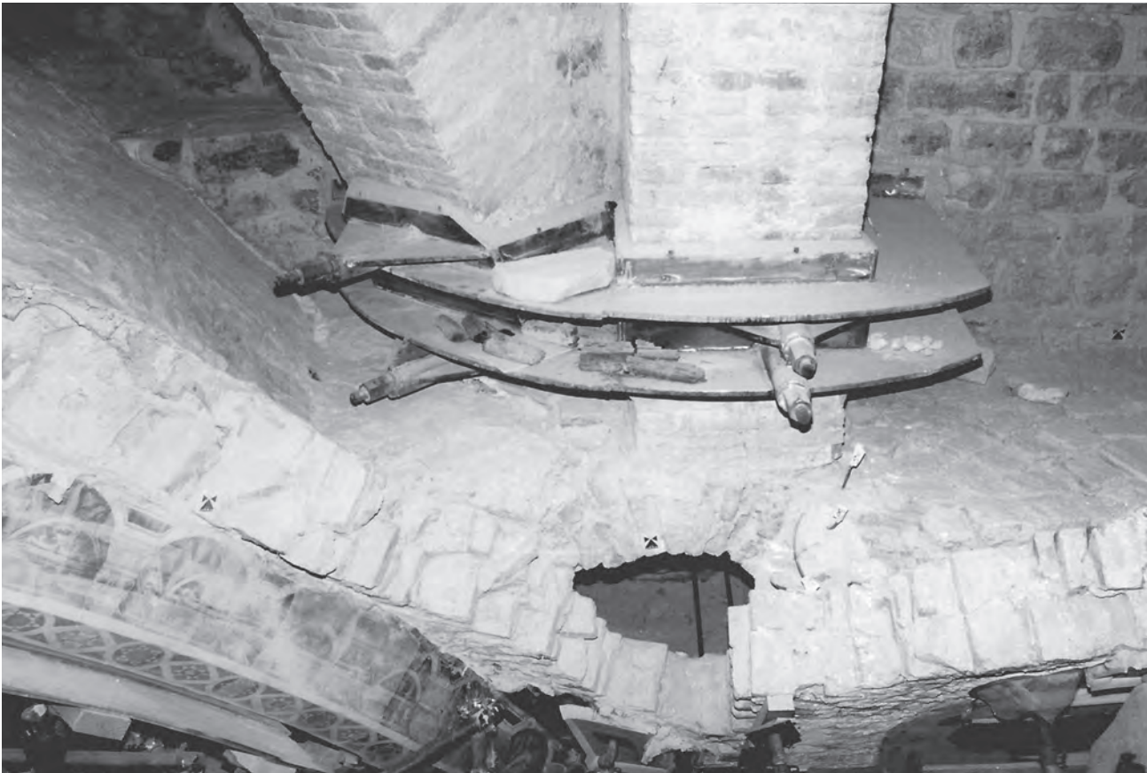
Fig. 6 – Assisi, complesso conventuale di San Francesco, sottotetto, particolare dell'impasta dell'arcone che sostiene la copertura della navata adiacente alla facciata. La struttura poggia "in falso" su di un sistema di voltine a sesto acuto che lascia un vuoto al piede dell'appoggio (foto di Spiridione Alessandro Curuni, 1999).
