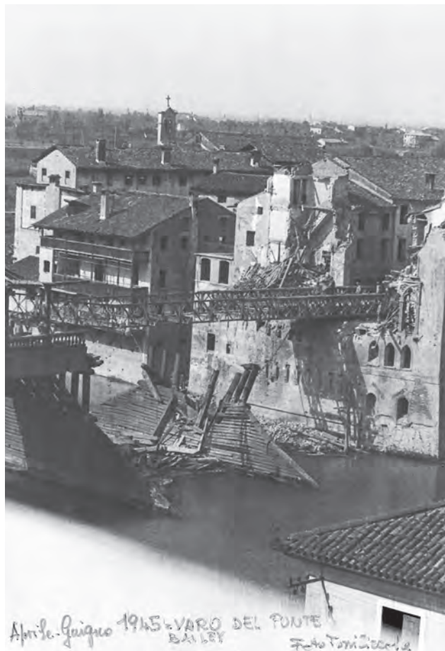
Fig. 3 – Bassano, varo del ponte Bailey, poco dopo la distruzione del Ponte Vecchio, 1945 (foto Comune di Bassano del Grappa).
