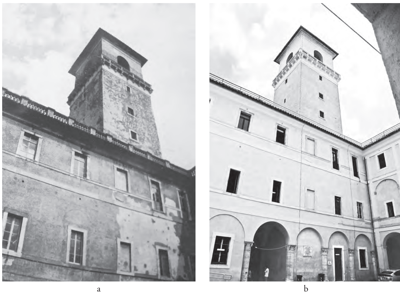
Fig. 4 – Monterotondo, palazzo Comunale, il mastio prima degli interventi di restauro sulle superfici architettoniche del 2007-2008 (a) (da MARCHETTI 1981, p. 36, fig. 18); il torrione dalla corte principale, stato attuale (b) (foto dell'autrice).
