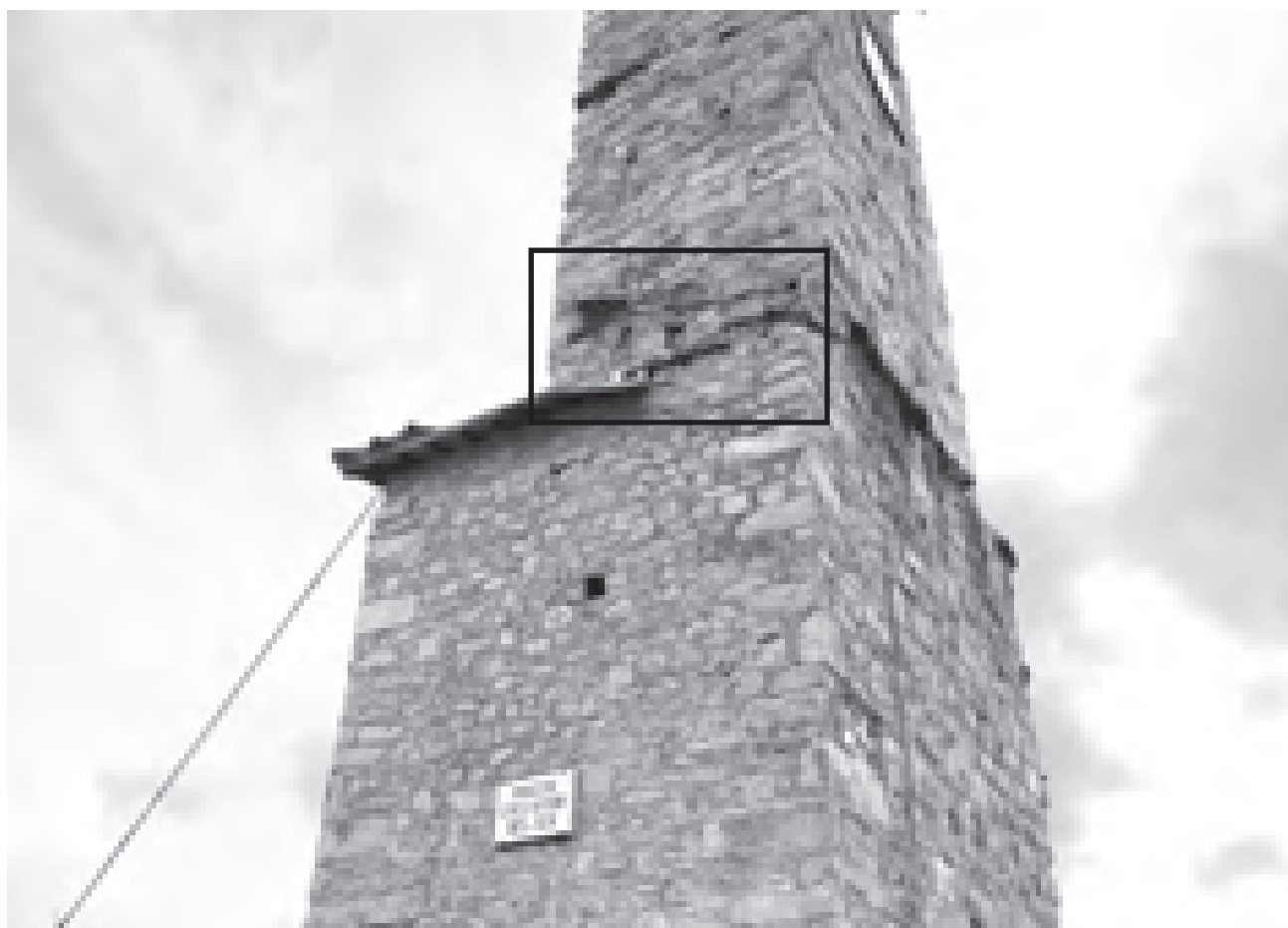
Fig. 8 – Amatrice, dettaglio delle tracce di una copertura addossata al campanile, 2017 (foto dell'autore).
