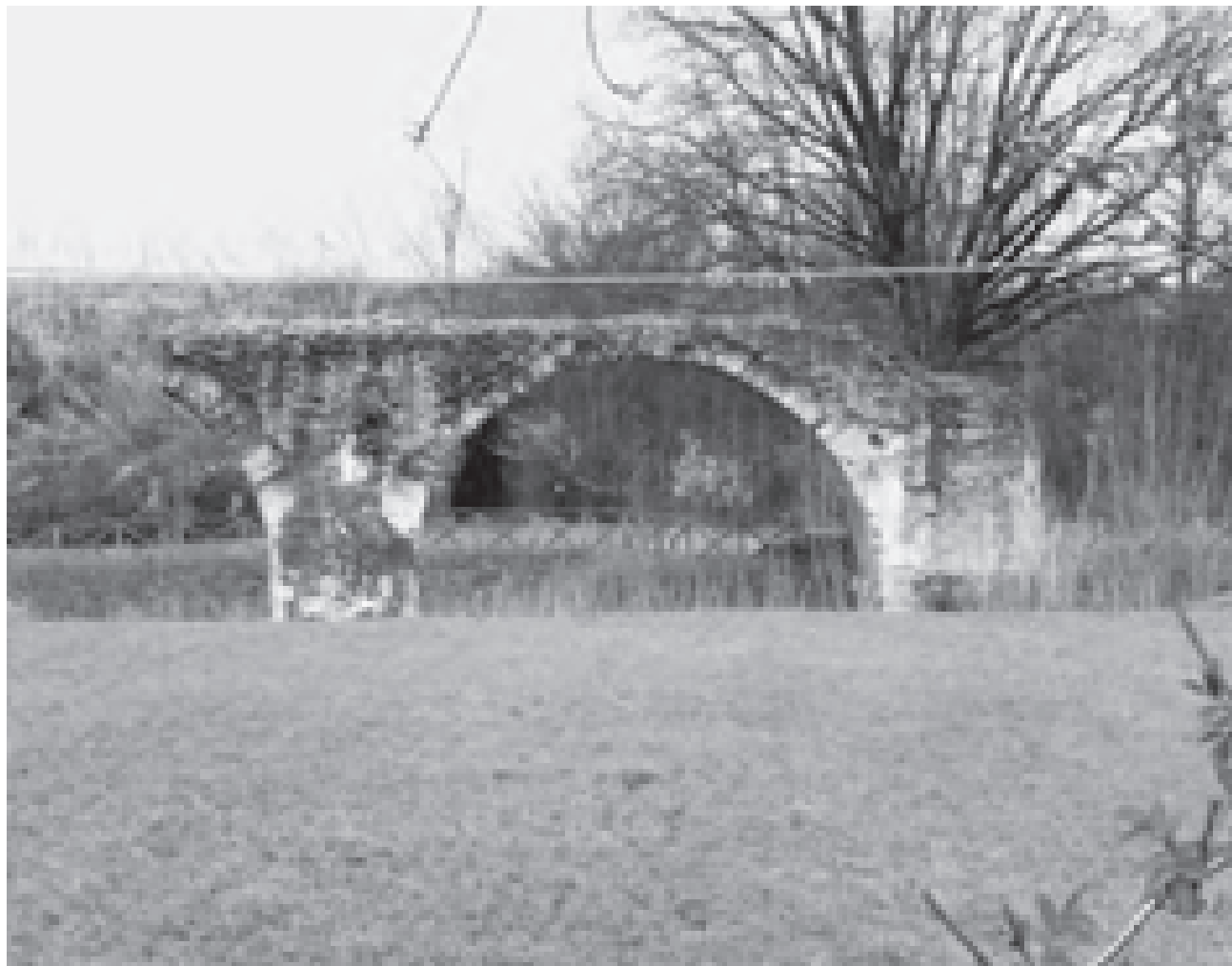
Fig. 7 – Santarcangelo di Romagna, Ponte «antico ruinato» sul fiume Uso, veduta d'insieme (foto dell'autore).
