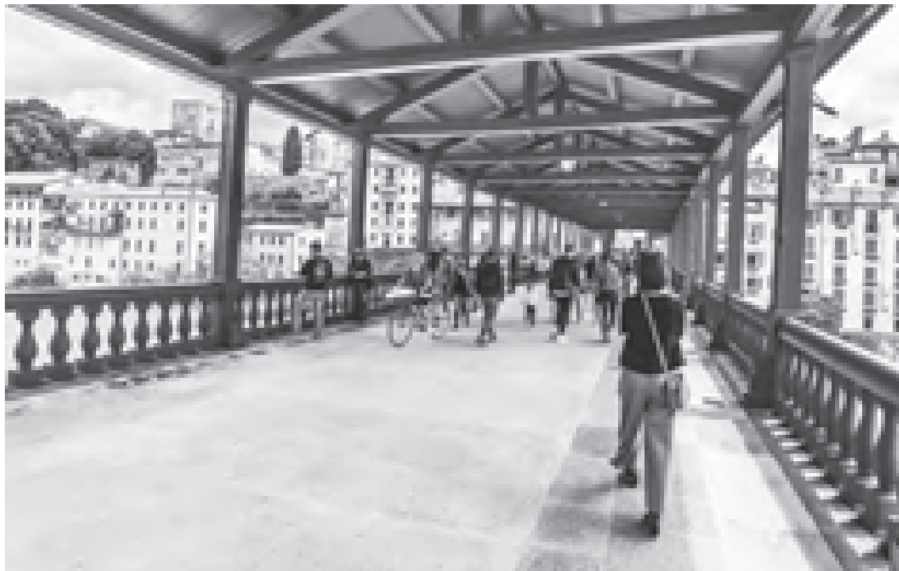
Fig. 15 – Bassano, il Ponte Vecchio o degli Alpini, dopo la riapertura al pubblico, maggio 2021 (foto Comune di Bassano del Grappa).
