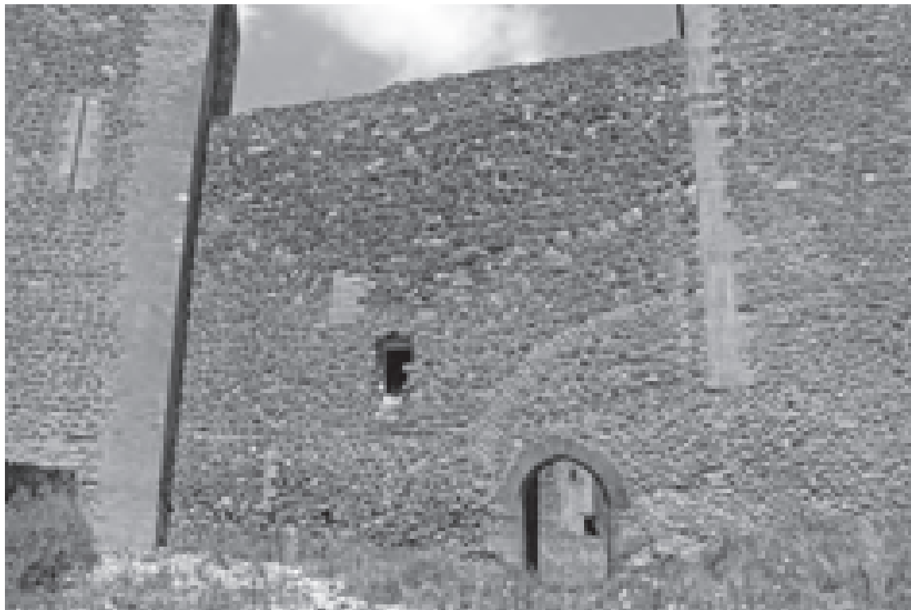
Fig. 9 – Melfi, castello, “Cortile degli Armigeri”, lato nord (foto dell'autrice).
