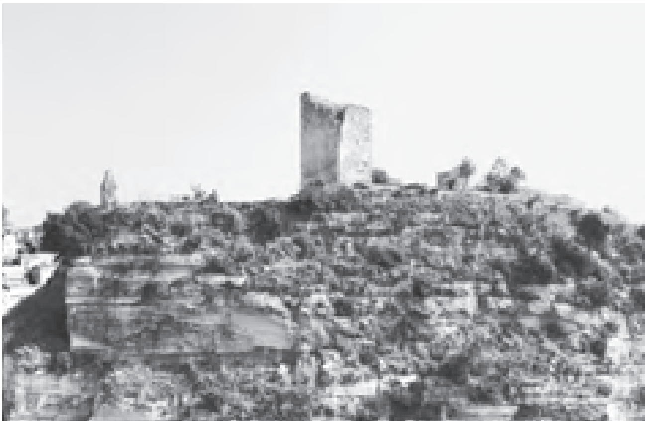
Fig. 5 – Condojanni (RC). Veduta del castello da sud con il torrione al centro (foto dell'autrice).
