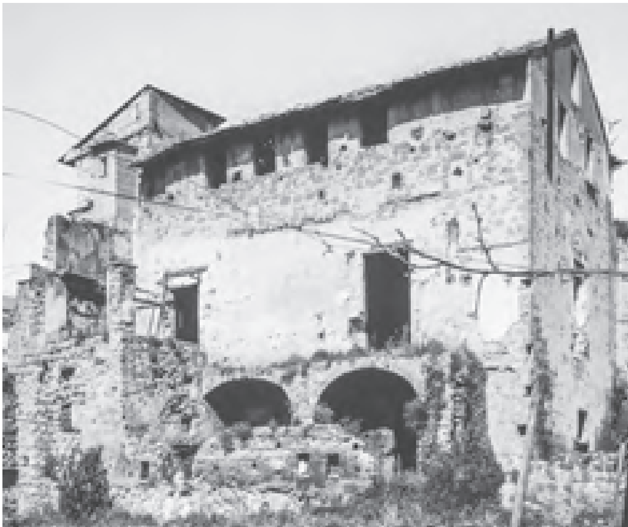
Fig. 8 – Aversa, edificio in vico San Giovanni 8, scorcio dal giardino del volume nord-orientale, di impianto romanico, con trasformazioni gotiche (foto GIUSEPPE FIENGO, 1996).
