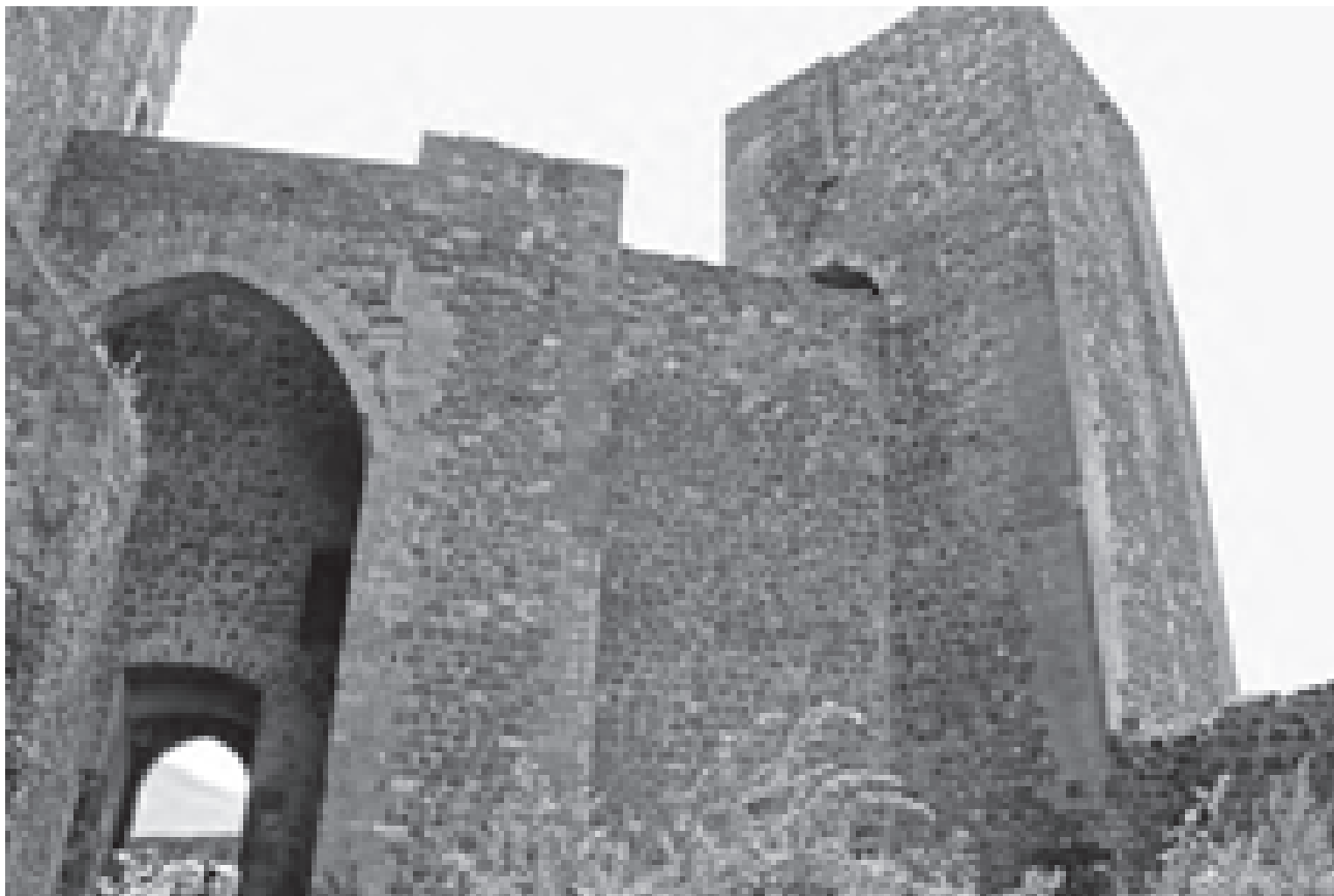
Fig. 8 – Melfi, castello, “Cortile del Mortorio”, lato sud (foto dell'autrice).
