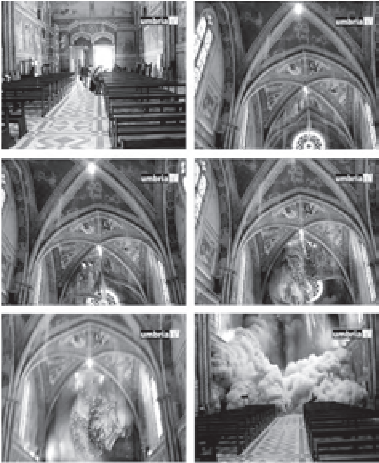
Fig. 2 – Sequenza di immagini che riprendono il crollo della volta della basilica superiore in seguito alla scossa sismica del 27 settembre 1998. Si noti la deformazione e poi la rottura del costolone della volta, e della relativa vela, e la caduta della muratura insieme al copioso materiale di riempimento accumulatosi nei rinfianchi delle volte (fotogrammi ricavati dal video diffuso sulle reti regionali e nazionali, 1997).
