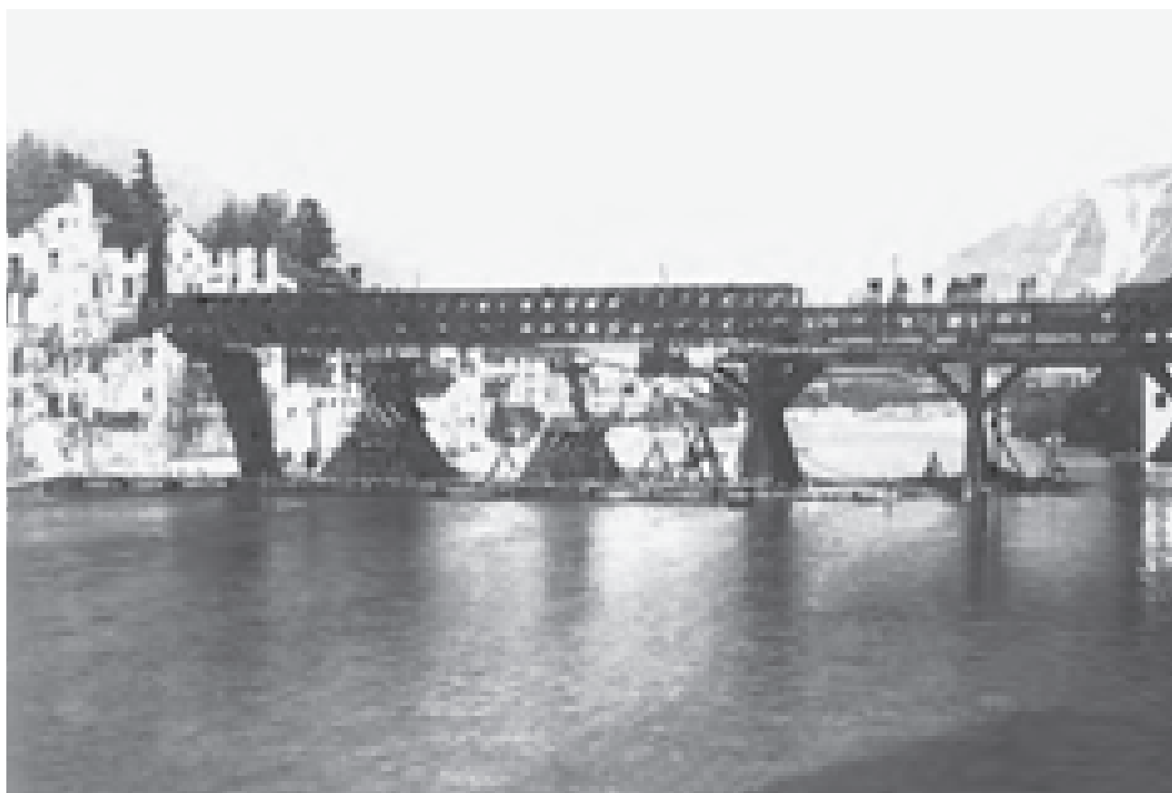
Fig. 4 – Bassano, il Ponte Vecchio quasi del tutto demolito, 1946 (foto Comune di Bassano del Grappa).
