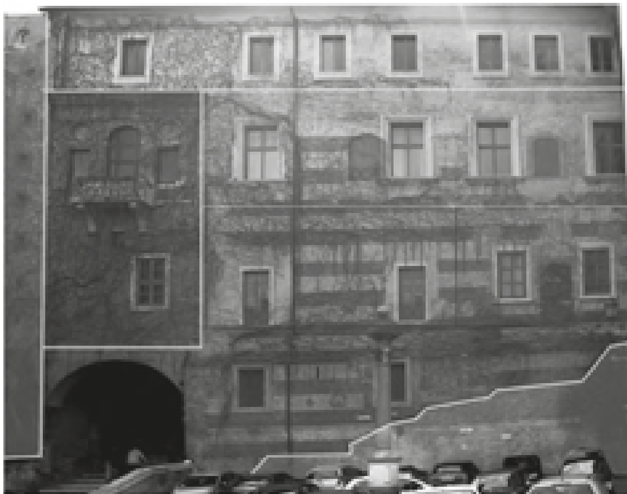
Fig. 7 – Roma, complesso di San Francesco di Paola ai Monti, fasi di costruzione di Palazzo Cesarini tra l’XI e il 1723. In basso a destra è evidenziata la sagoma della scala d’accesso al palazzo demolita probabilmente nell’ambito dei lavori di costruzione dell’ala settecentesca del convento. A sinistra è indicata la parte del prospetto relativa alla torre medievale inglobata nel palazzo; al di sopra del passaggio ad arco verso San Pietro in Vincoli è ben visibile la porzione costruita presumibilmente negli anni Settanta del Cinquecento. In alto, in corrispondenza dell’ultimo livello, si può notare il piano aggiunto in occasione dell’ampliamento settecentesco (elaborazione grafica dell’autore).
