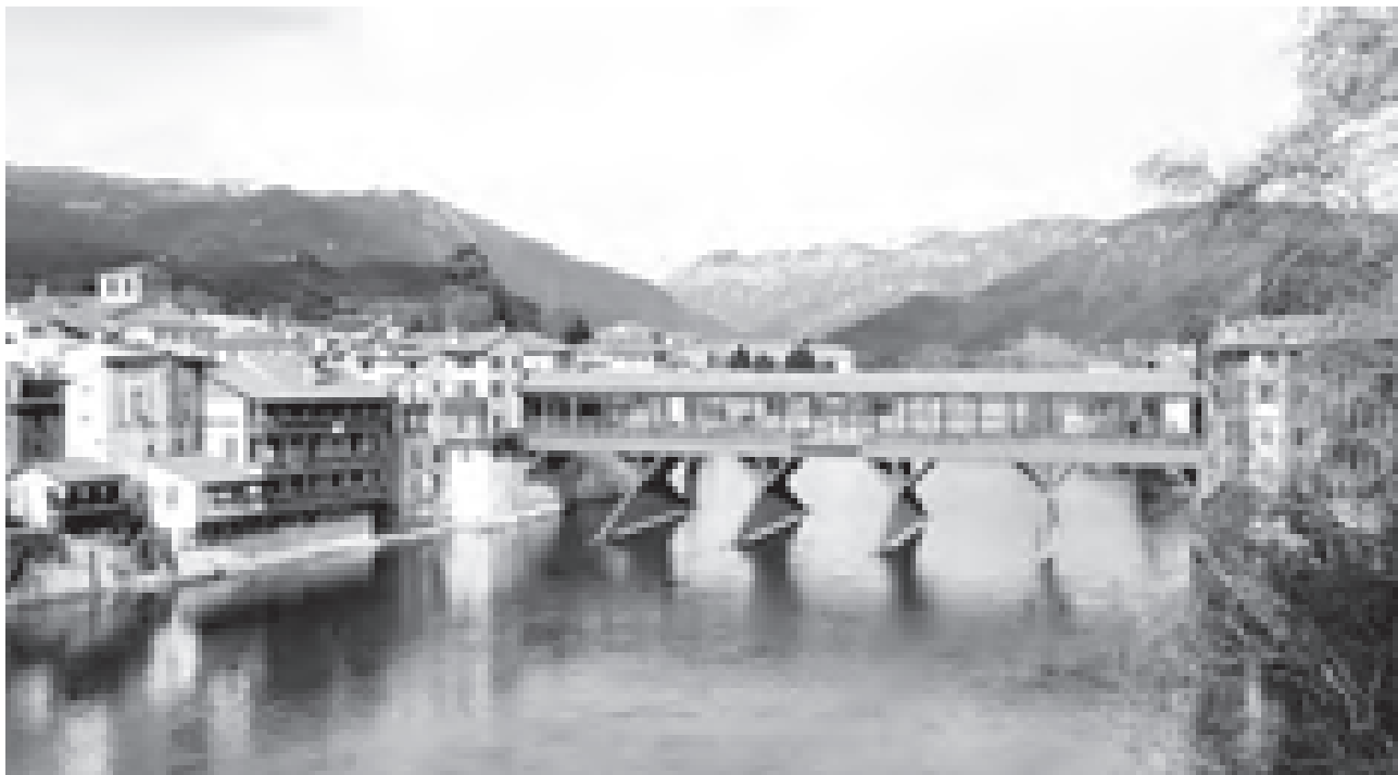
Fig. 14 – Bassano, Ponte Vecchio, il nuovo restauro pressoché ultimato, inizi 2021 (foto Comune di Bassano del Grappa).
