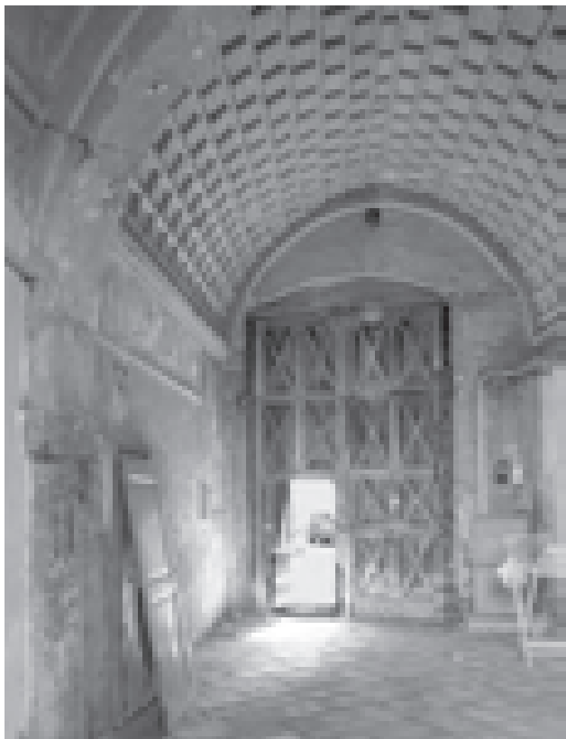
Fig. 10 – Aversa, edificio in vico San Giovanni 18, vestibolo, scorcio, verso l'ingresso, della volta a botte cassettonata, 2017 (foto dell'autore, 2017).
