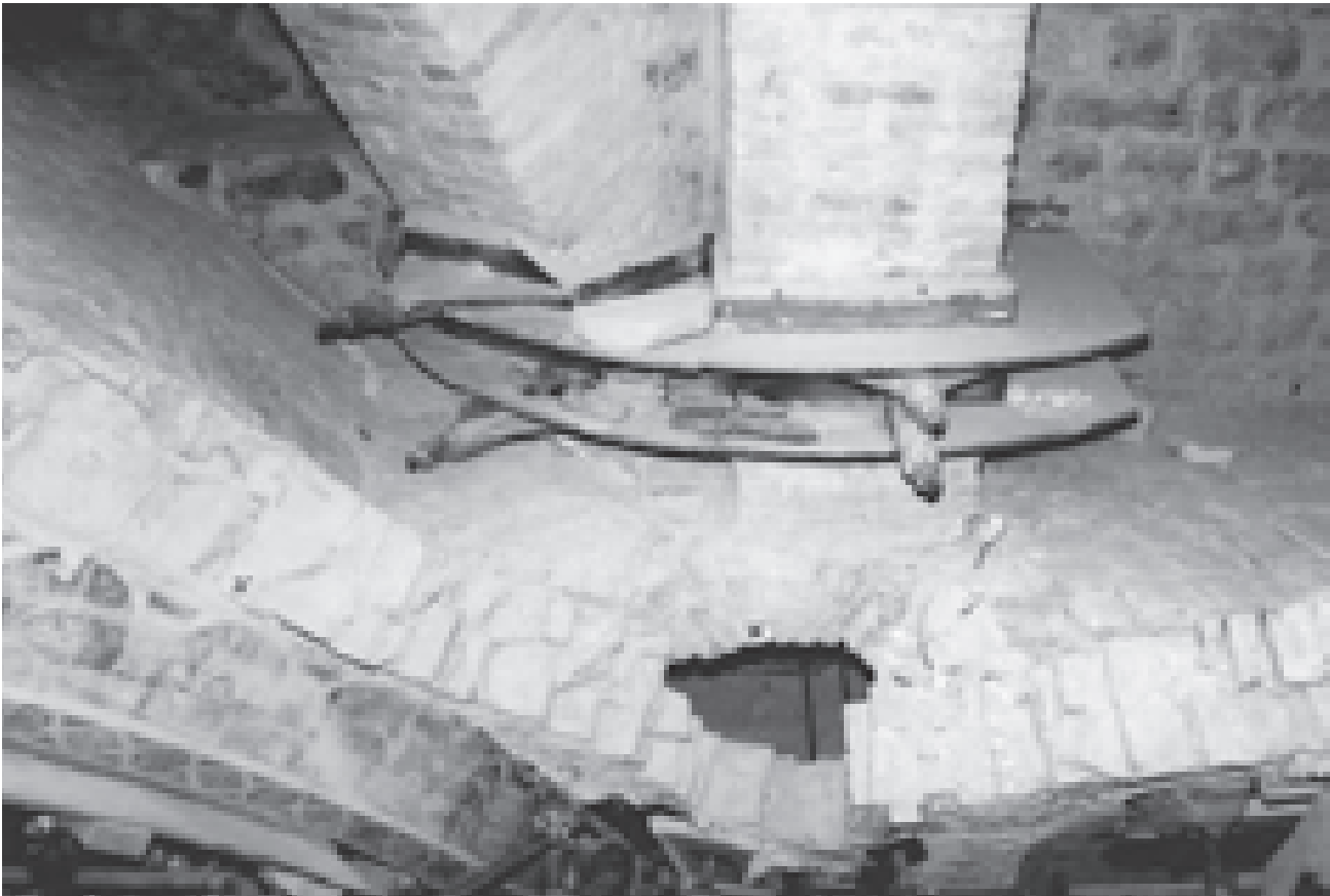
Fig. 6 – Assisi, complesso conventuale di San Francesco, sottotetto, particolare dell’imposta dell’arcone che sostiene la copertura della navata adiacente alla facciata. La struttura poggia “in falso” su di un sistema di voltine a sesto acuto che lascia un vuoto al piede dell’appoggio (foto di Spiridione Alessandro Curuni, 1999).
