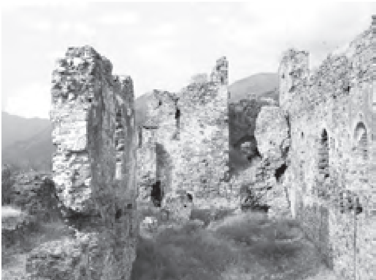
Fig. 4 – Amendolea (RC). Sullo sfondo, al centro, la torre A, su cui si appoggia a destra la torre B (foto dell'autrice).
