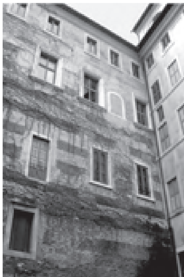
Fig. 6 – Roma, complesso di San Francesco di Paola ai Monti, dettaglio della facciata di Palazzo Cesarini prospiciente via Cavour; si possono notare chiaramente le diverse murature che denunciano le stratificazioni leggibili sull'edificio (foto dell'autore).
