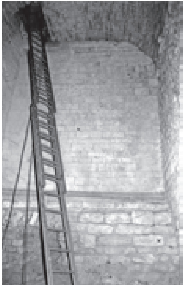
Fig. 11 – Assisi, complesso conventuale di San Francesco, ambiente sottostante la Loggia delle Benedizioni, compreso tra la piazza superiore e l'atrio d'ingresso della basilica inferiore. Si notano la cornice superiore in pietra calcarea che marca il piano fra basilica superiore e inferiore, il paramento in filari orizzontali di conci di pietra calcarea finemente lavorati corrispondente al risvolto sinistro della facciata, la cornice in basso che raccorda lo spiccatto della parete che poggia sul banco roccioso, la copertura a botte in laterizio aggiunta successivamente (foto dell'autrice, 1999).
