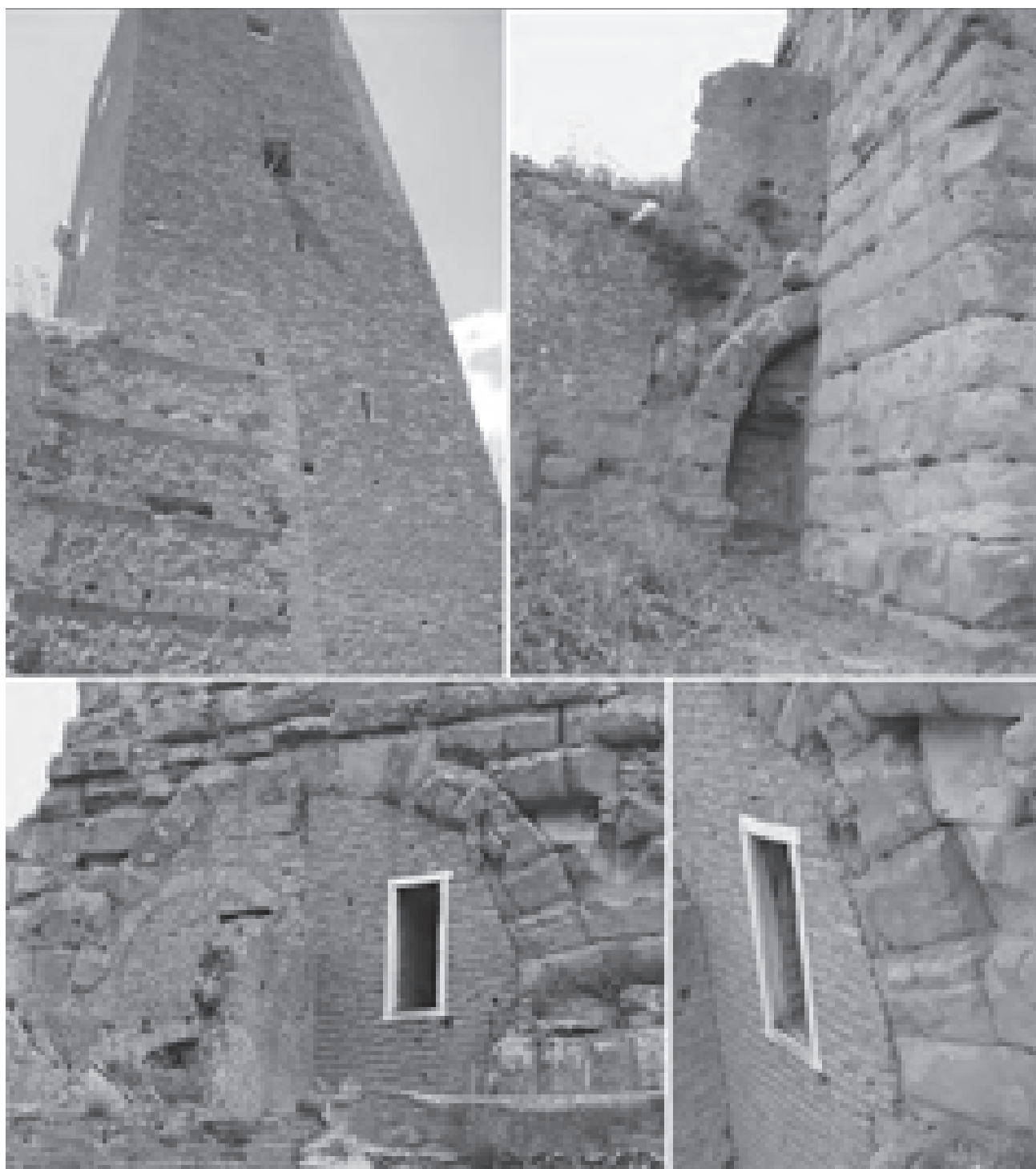
Fig. 5 – Roma, Torre del Fiscale, alcune immagini che danno conto della complessa articolazione del manufatto; in alto: a sinistra, la torre medievale sovrapposta alla muratura antica dell'edificio addossato agli acquedotti; a destra, una delle poche arcate residue del Marcio che attraversa il fornice del Claudio, molto più alto; in basso, l'arcata del Claudio che manifesta, sopra alla finestra con imbotti di travertino nel setto a tufelli (corrispondente all'elevazione della torre soprastante), vistosi fenomeni di degrado degli elementi lapidei, frantumati e parzialmente distaccati o mancanti; a destra, un particolare dello stesso ghiera. Si consideri che a sinistra del setto a tufelli, la muratura, non direttamente gravata dalla torre, potrebbe essere successiva, realizzata solo come tamponatura non portante del resto dell'arcata (foto dell'autore).
