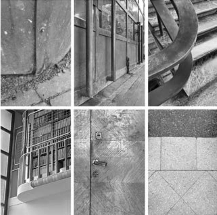
Fig. 8. Da sinistra in alto: dettaglio della camicia in Similorò di uno dei piloni di sostegno della pensilina d'ingresso; struttura della porta d'accesso principale in Similorò; profili della ringhiera in Similorò dello scalone interno; parapetto in lega di alluminio nella sala del consiglio; porta interna in legno con minuteria metallica; marmette di graniglia con impasto e materiale lapideo sui toni del verde e del giallo nella pavimentazione di un'aula (foto G. Favaretto 2023).
