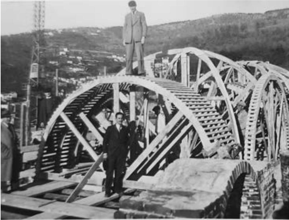
Fig. 3. La costruzione delle centine per le volte dei portici dell'edificio principale durante la fase di cantiere; 27-11-1940 (ASTs, *Genio Civile*, b. 1257).
