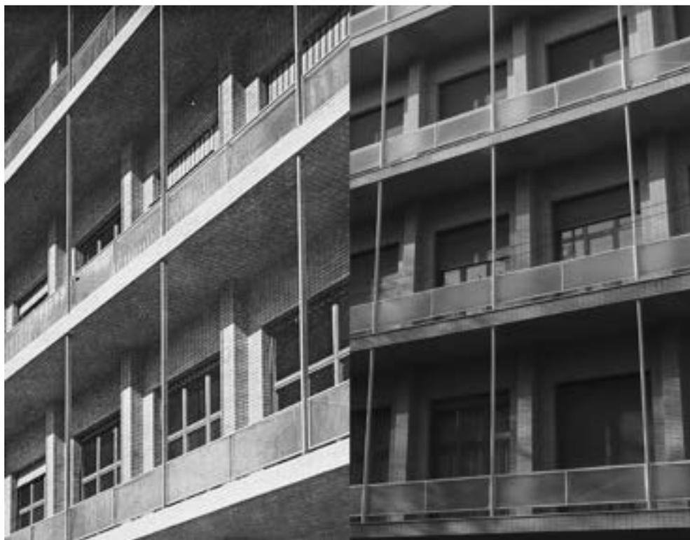
mica, oltre che significative infiltrazioni d'acqua nella soletta in calcestruzzo armato<sup>14</sup>. In quell'occasione, l'aggancio delle piantane è stato spostato all'intradosso delle solette sulle quali si appoggiano, in assenza di incastri, utilizzando una lastra in neoprene per ammortizzare le dilatazioni termiche. Contestualmente sono state impermeabilizzate le logge e sono stati ripristinati i rivestimenti in pietra di Finale e litoceramica<sup>15</sup> (Fig. 5).
