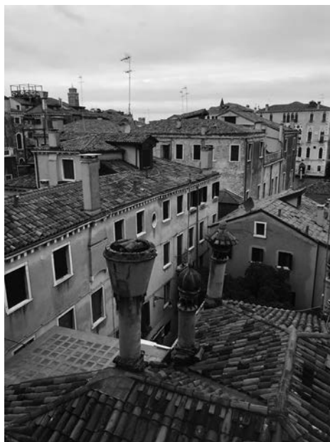
Fig. 8. Venezia, palazzetto prospiciente rio di Ca' Corner nel sestiere di San Marco. In primo piano i comignoli sveltanti della copertura.
