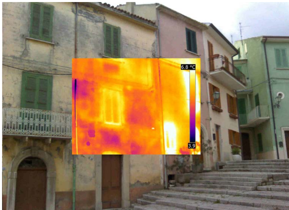
Fig. 7. Trivento (CB), termografia effettuata su una porzione dell'edilizia di base del centro storico caratterizzante l'aggregato urbano.
