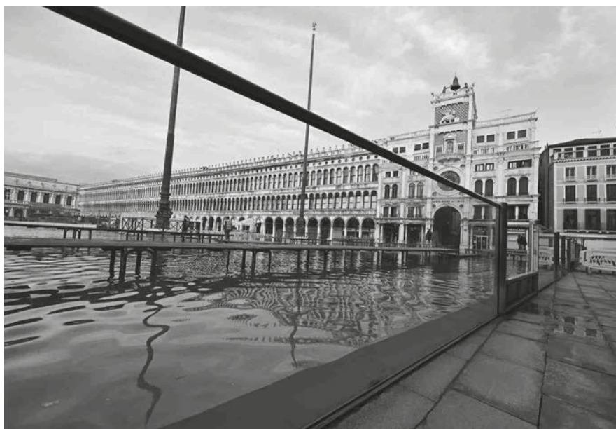
Fig. 4. Venezia, la nuova barriera fissa in cristallo e acciaio per l'acqua alta collocata a protezione della Basilica di San Marco (foto Pierpaolo Campostrini, 2023).
