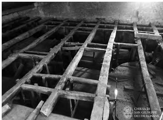
Fig. 6. Roma, chiesa di San Giuseppe dei Falegnami. Veduta dell'estradosso della porzione di soffitto non crollata nel 2018 in cui si può apprezzare la regolarità nella disposizione degli arcarecci superiori per la presenza del calpestabile superiore e l'uso di traverse per l'ancoraggio dei montanti verticali ( https://www.san-giuseppedeifalegnami.org ).
