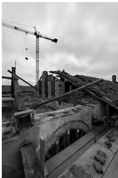
Fig. 8. Stato ante operam degli appoggi sulle murature interne (2022).
