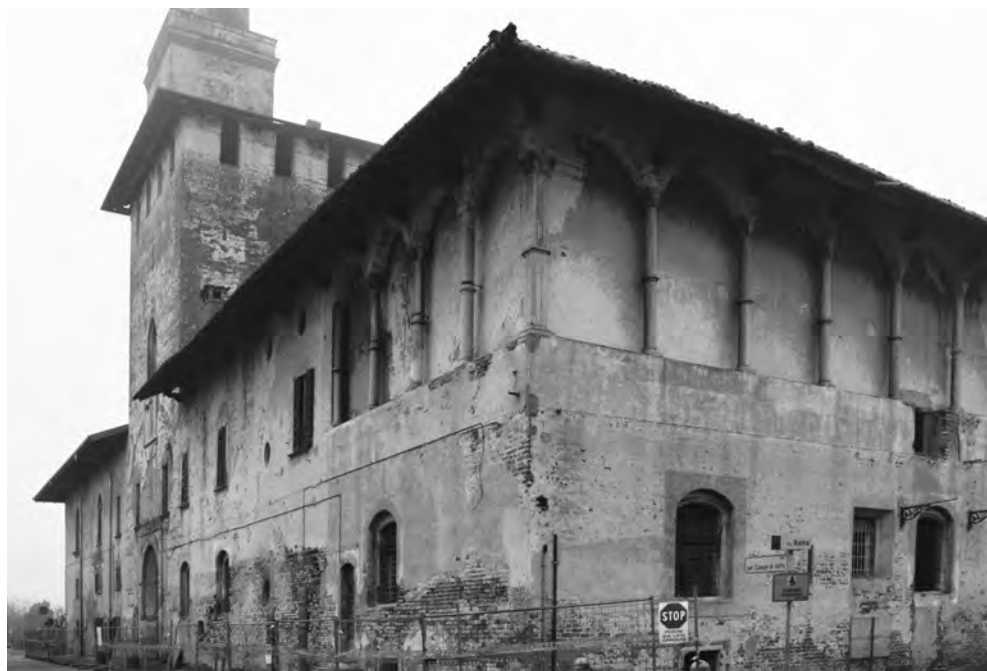
Fig. 2. La loggia: stato ante operam (2022).
