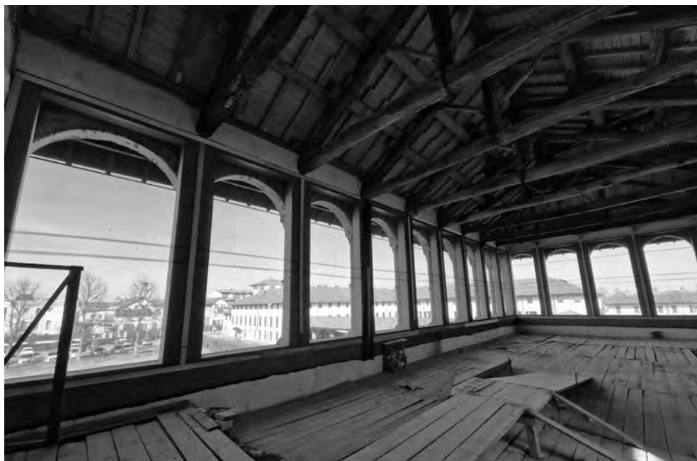
Fig. 10. Interno della loggia del castello a seguito della rimozione delle tamponature e degli interventi di consolidamento (2023).
