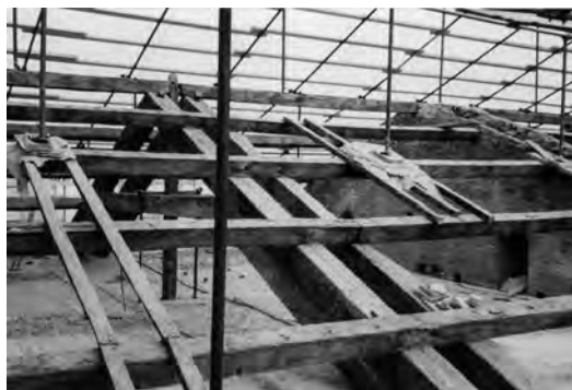
Fig. 5. La tipologia della capriata binata con monaco singolo passante tra le due controcatene, già rappresentata dettagliatamente in LETAROUILLY 1840, come appare nella copertura di Santa Prassede (foto Maurizio Caperna).
