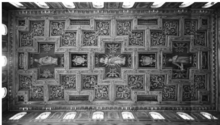
Fig. 8. Roma, basilica di Sant'Agnese fuori le mura. Ortofoto del soffitto a lacunari realizzato nel 1606 per volere del cardinal Paolo Emilio Sfondrati.
