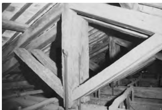
Fig. 6. Nella capriata binata presente a San Giorgio al Velabro si osserva uno schema diverso in cui anche il monaco si raddoppia per sostenere le saette; la tipologia è quindi costituita da una doppia incavallatura, ripetuta identica, appaiata e solidarizzata dai connettori (da La chiesa di San Giorgio 2002, p. 82).
