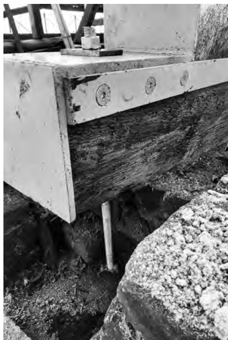
Fig. 7. Coperture dell'ala nord: esempio del nuovo sistema di connessione alle murature (2021).
