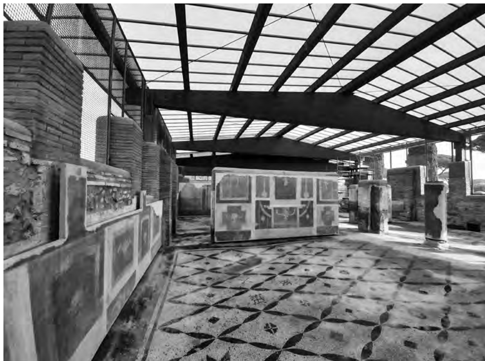
Fig. 6. Insula delle Ierodule, la copertura in legno lamellare e policarbonato.
