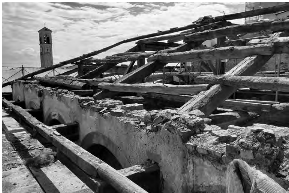
Fig. 1. Castello Visconteo di Cusago (MI), coperture dell'ala nord: orditure della loggia secondo lo schema costruttivo del 'tetto alla lombarda' (2021).
