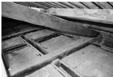
Fig. 3. Roma, chiesa di San Marco al Campidoglio. Veduta dell'estradosso del soffitto; le tavole di conformazione dei lacunari sono ancorate direttamente alle catene delle capriate.
