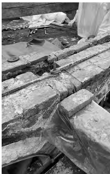
Fig. 4. Particolare della catena estradossale originaria della loggia: arpionatura d'angolo (2021).
