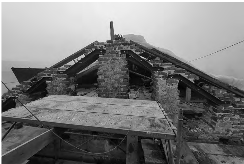
Fig. 9. Stato post operam degli appoggi sulle murature interne (2022).
