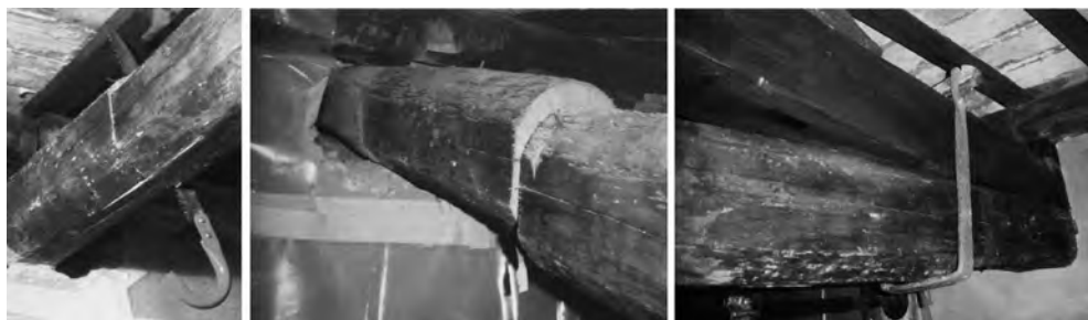
Fig. 9. Mosaico di istantanee relative alla sostituzione (1996) di un puntone nella campata destra di San Giorgio al Velabro riprese nella fase di rimozione della trave inclinata, eseguita evitando l'interessamento dell'orditura secondaria (foto Anelinda Di Muzio, in Archivio corrente della Soprintendenza di Roma, b.149, Perizia di spesa n. 80 - 1992).
