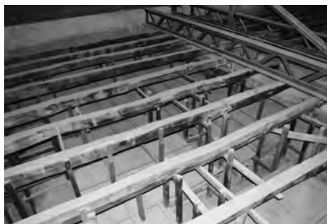
Fig. 4. Roma, chiesa dei Santi Cosma e Damiano. Veduta dell'estradosso; il soffitto è realizzato con un sistema di telai appesi ad arcarecci superiori che poggiano sulle catene delle capriate.
