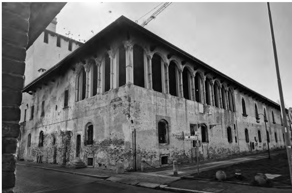
Fig. 11. La loggia: stato post operam (2023).
