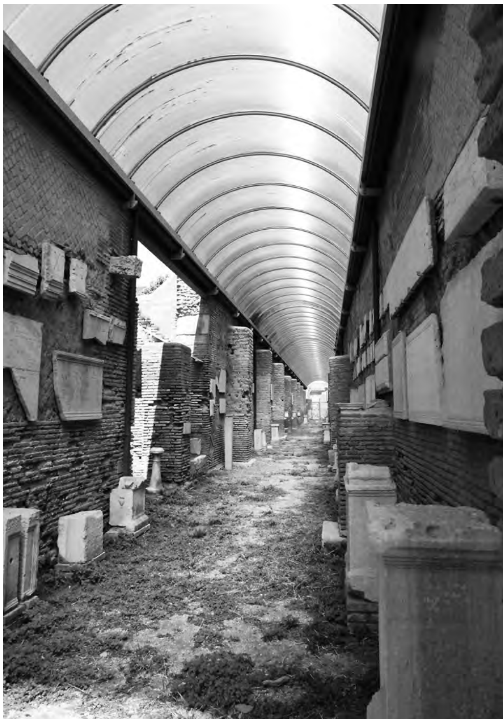
Fig. 5. Galleria Lapidaria, copertura in acciaio e policarbonato.
