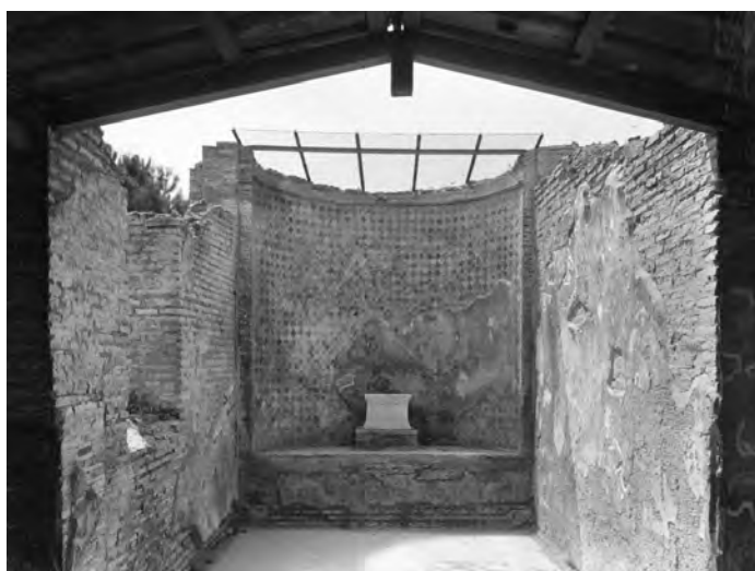
Fig. 4. Sacello delle Tre Navate, la copertura in vetro e metallo posta a protezione dell'abside (ICCD, inv. E40716).
