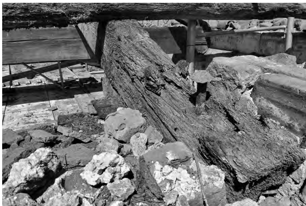
Fig. 6. Coperture dell'ala nord: esempio dell'originario sistema di connessione alle murature (2021).
