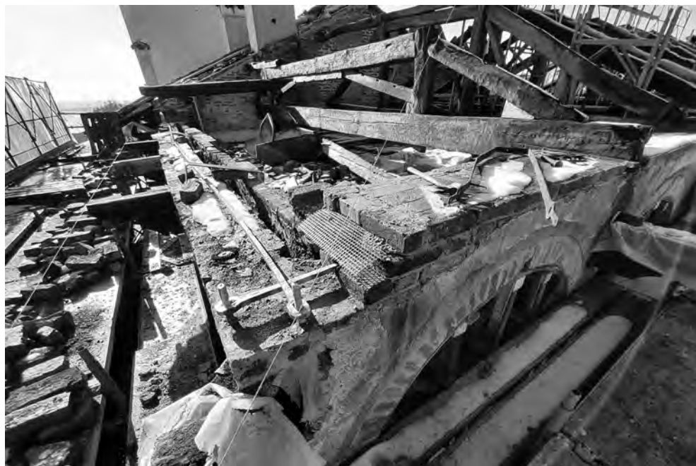
Fig. 4. Particolare della catena estradossale originaria della loggia: arpionatura d'angolo (2021).
