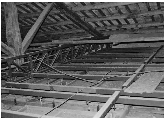
Fig. 7. Roma, chiesa di San Cesareo in Palatio . Veduta dell'attuale sistema di ancoraggio metallico del soffitto che, intorno agli anni Sessanta del secolo scorso, ha sovvertito il criterio costruttivo originale.
